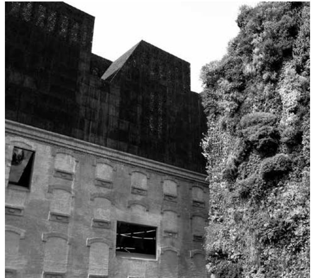
Fig. 3. - Caixa Forum en Madrid. Proyecto de reestructuración de Herzog & de Meuron, 2001-07: Llevar al extremo un proyecto en el que la aplicación técnica, con una buena “dosis de músculo”, se convierte en desafío y superación de la compatibilidad. «A construction below and a construction above ground [where] the separation of the structure from the ground level creates two worlds: one below and the other above the ground. [...] There is a contrast between the flexible and loft-like character of the exhibition spaces and the spatial complexity of the top floor [...] The surprising sculptural aspect of the CaixaForum’s silhouette is no mere architectural fancy, but reflects the roofscape of the surrounding buildings». Fuente: www.herzogdemeuron.com/index/projects/complete-works/201-225/201-caixaforum-madrid.html . Fotografía de Roberta Sassone, 2011.
