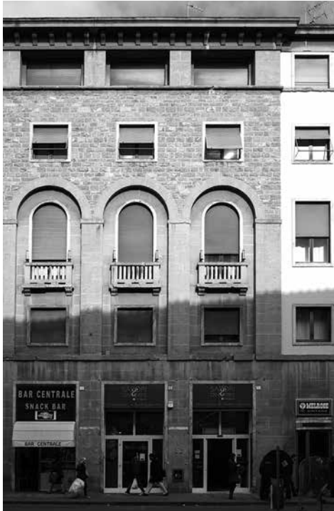
Fig. 11. - Cine Italia en Florencia, actualmente convertido en supermercado. Fotografía de Roberta Sassone, 2014.
