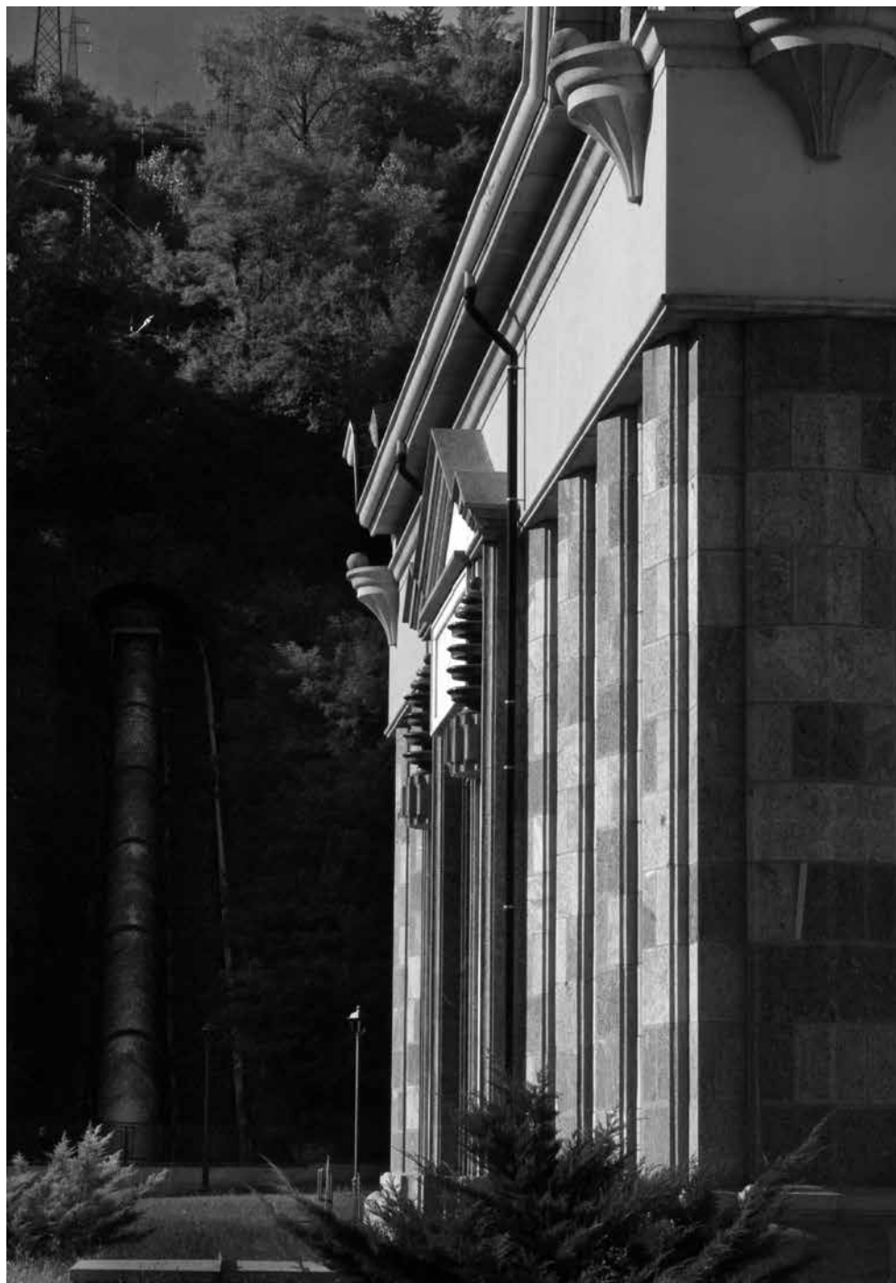
Fig. 1. - Centrale di Crevola Toce (VB) di Piero Portaluppi, del 1925. Particolare. Fotografia di Studio Publica, 2016.
