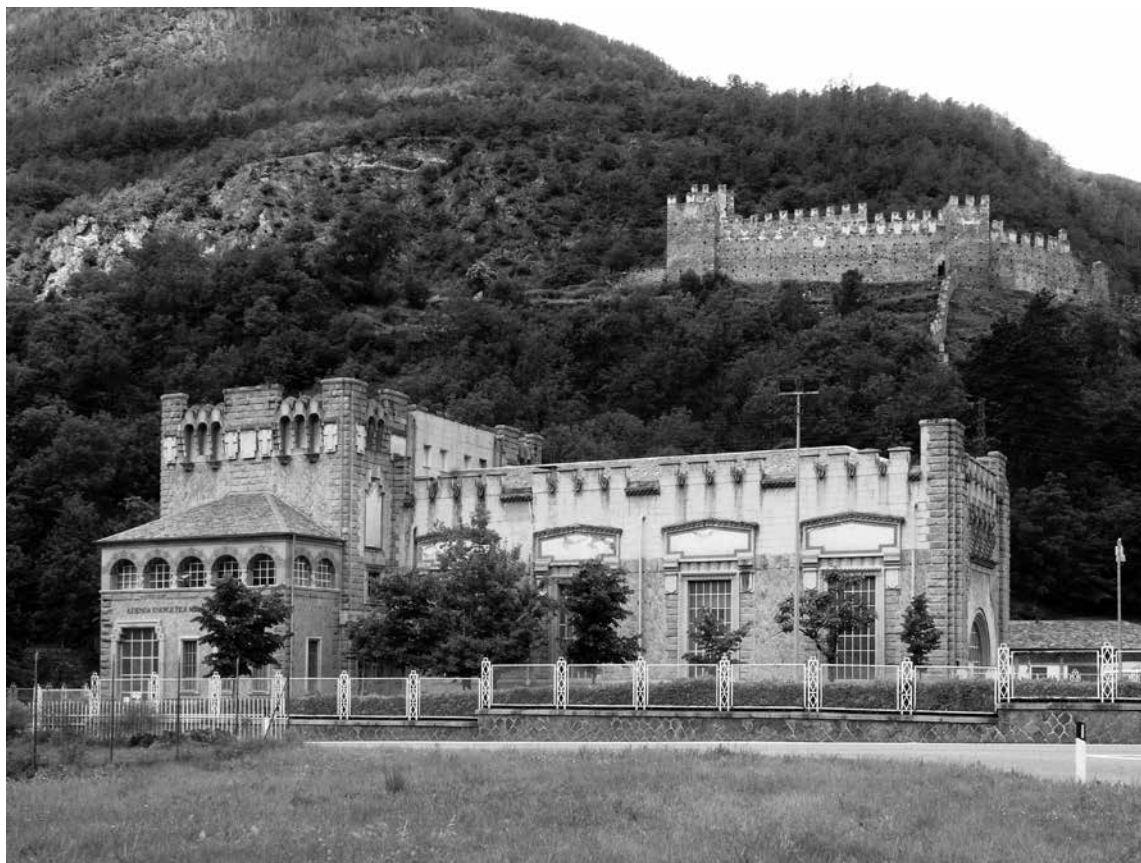
Fig. 4. - Piero Portaluppi, centrale del Groasco, Grosio, 1917-1920. Fotografia di Luciano Bolzoni.
