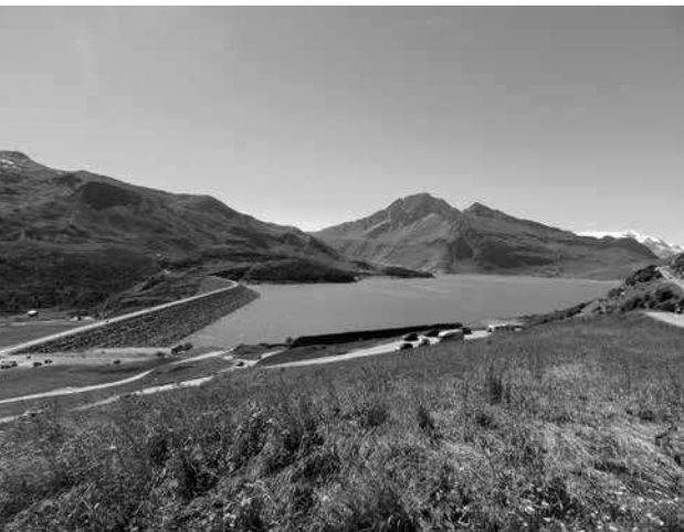
Fig. 1. - Presa y pantano de Moncenisio. Turín (Piamonte). La cuenca se realizó ampliando progresivamente el lago natural preexistente en tres fases sucesivas, mediante presas cada vez más grandes, en 1913, 1921 y 1968, año en el que se construyó la actual presa en tierra y piedra. Fotografía de Manuela Mattone.
