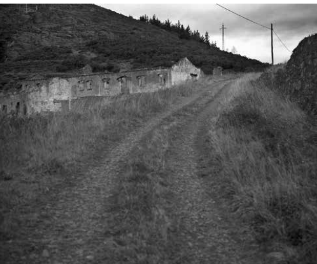
Fig. 7. - Pabellones de viviendas, al Oeste de la pista de acceso al poblado de la Paicega. Fotografía de Ángel Sanchís, 2003.
