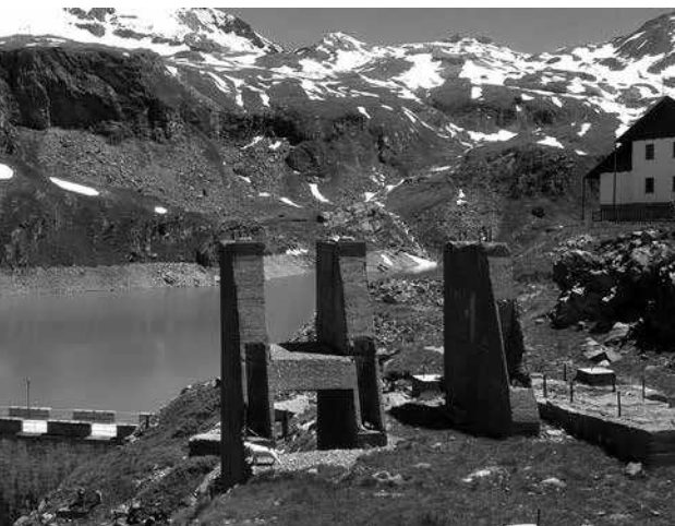
Fig. 2. - “Restos” de las obras de construcción de la presa de Goillet a los pies del monte Cervino: construcciones a las que nuestros ojos, que no han conocido este paisaje “antes” de la intervención de realización del embalse artificial, se han habituado. Fotografía de Elena Vigliocco, 2017.
