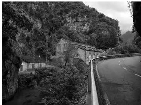
Fig. 11. - Integración en el paisaje de Somiedo del edificio del Salto Cueva de La Malva.
