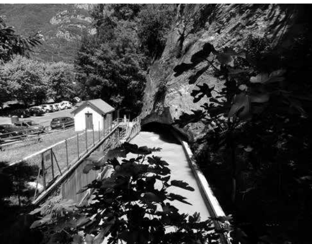
Fig. 6. - Pont Saint Martin (Valle de Aosta). Canalización a cielo abierto que conduce el agua a la central de Bard. Fotografía de Manuela Mattone.
