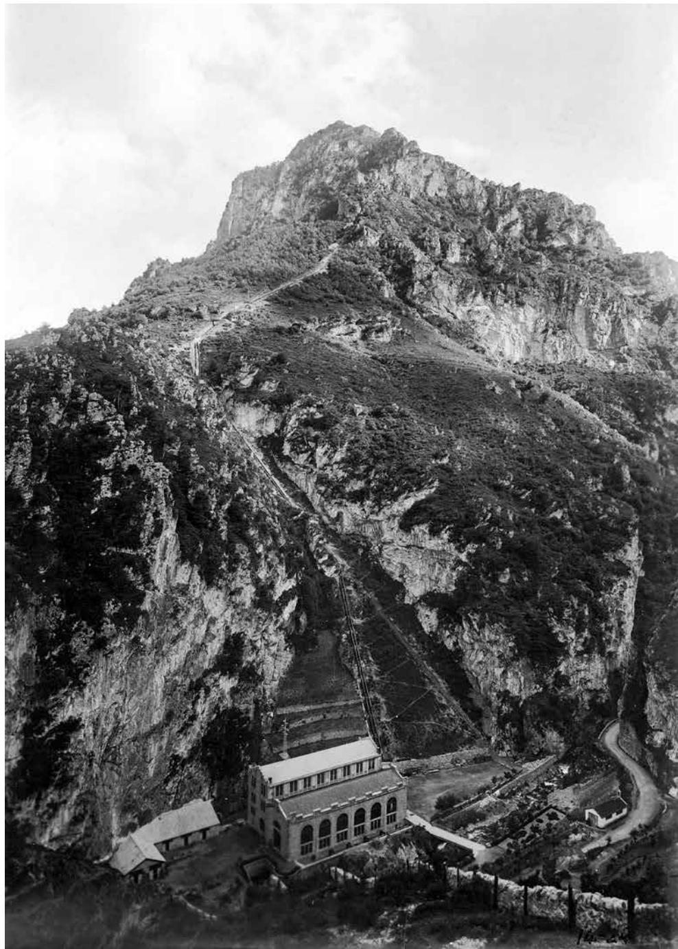
Fig. 8. - Vista general del salto con 570,5 m. de desnivel. Obsérvese la tubería forzada conectando la cámara de carga con el edificio de la central generadora. Fotografía del Archivo Histórico de Hidroeléctrica del Cantábrico.
