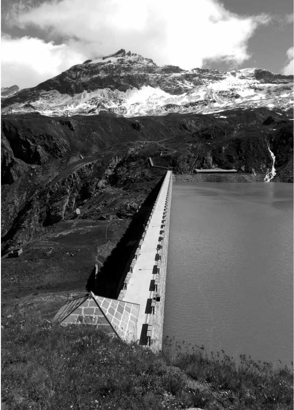
Fig. 2. - Presa de Goillet. Valtournenche (Valle de Aosta). La presa y su integración con el paisaje de montaña. Fotografía de Manuela Mattone.
