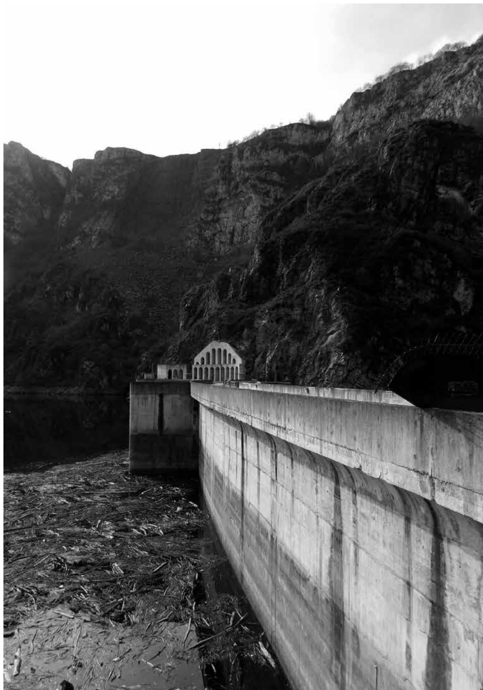
Fig. 16. - Central de Tanes. Fotografía de Manuela Mattone, 2016.
