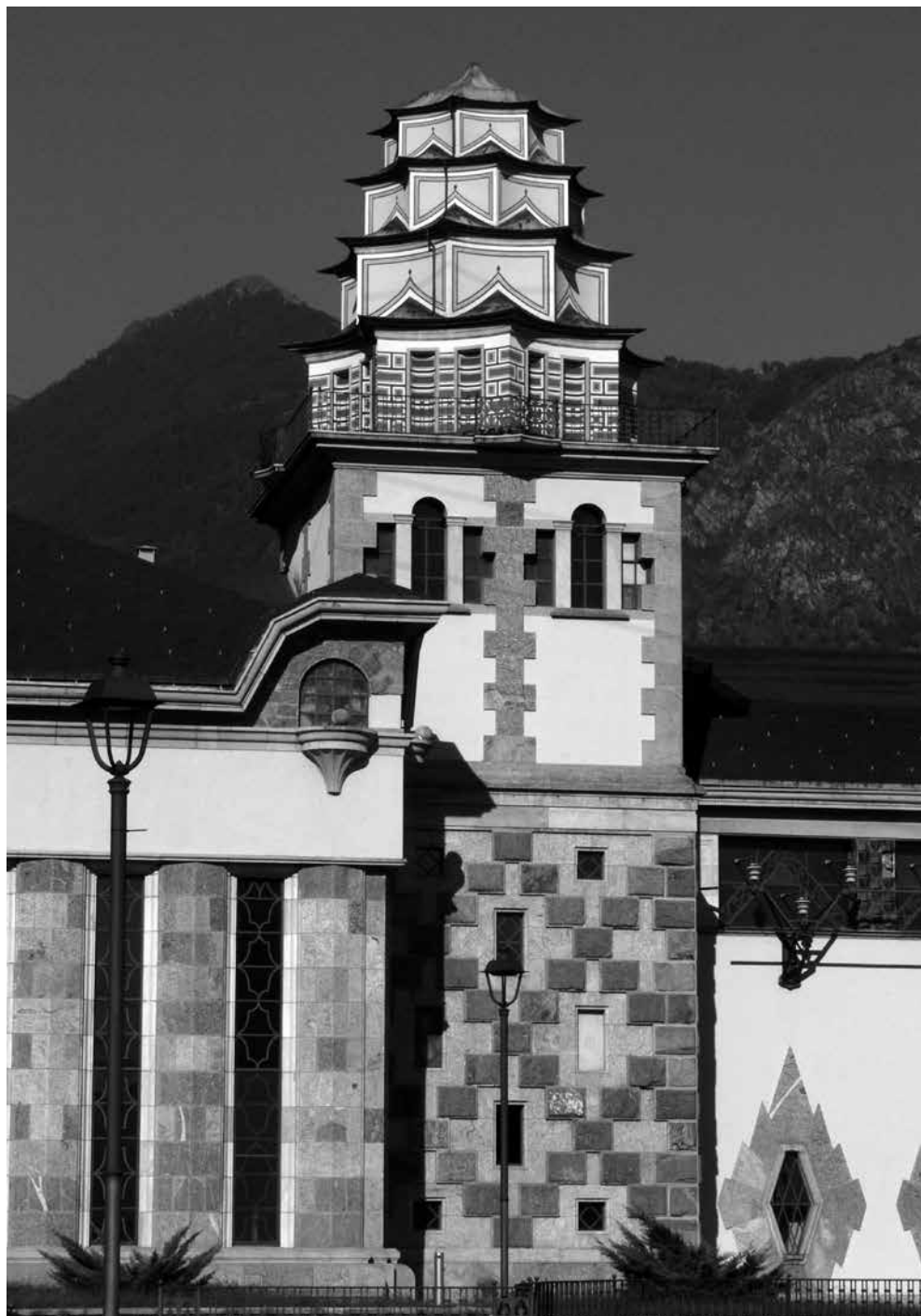
Fig. 3. - Centrale di Crevaladossola. Fotografia di Studio Publica, 2016.
