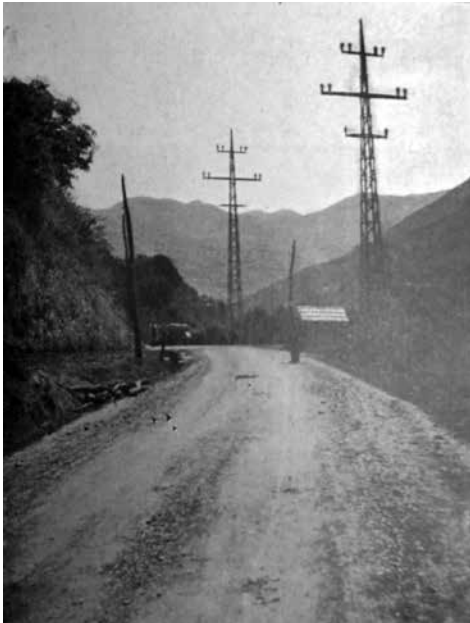
Fig. 10. - Torre de alta tensión para el transporte de la energía eléctrica. Memoria Descriptiva. Saltos de Agua de Somiedo . Oviedo; Hidroeléctrica del Cantábrico, 1917, p. 46.
