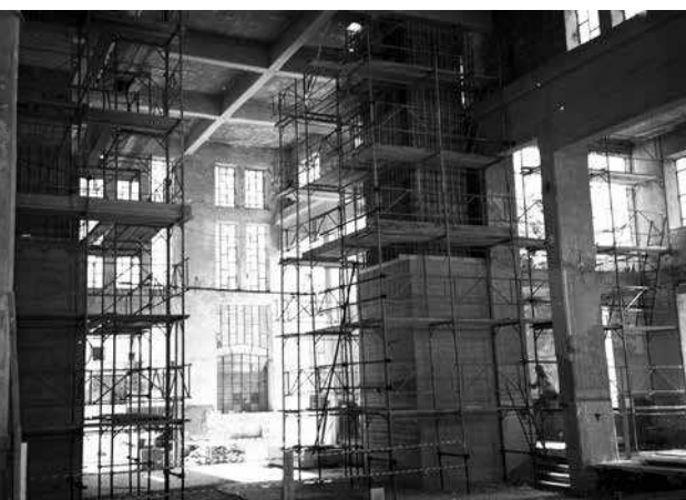
Fig. 3 e 4. - Teatro Ragazzi. Sopra: i lavori dello scavo della platea bassa esterna serviranno per liberare l'interrato. Si evidenzia il fronte a Est per sale didattiche, servizi, caffè. Sotto: Lavori in corso. Si costruiscono le colonne di servizio che sostenevano la balconata a bilanciere. Fonte: Cristina Banfo, archivio servizio edifici municipali Torino.
