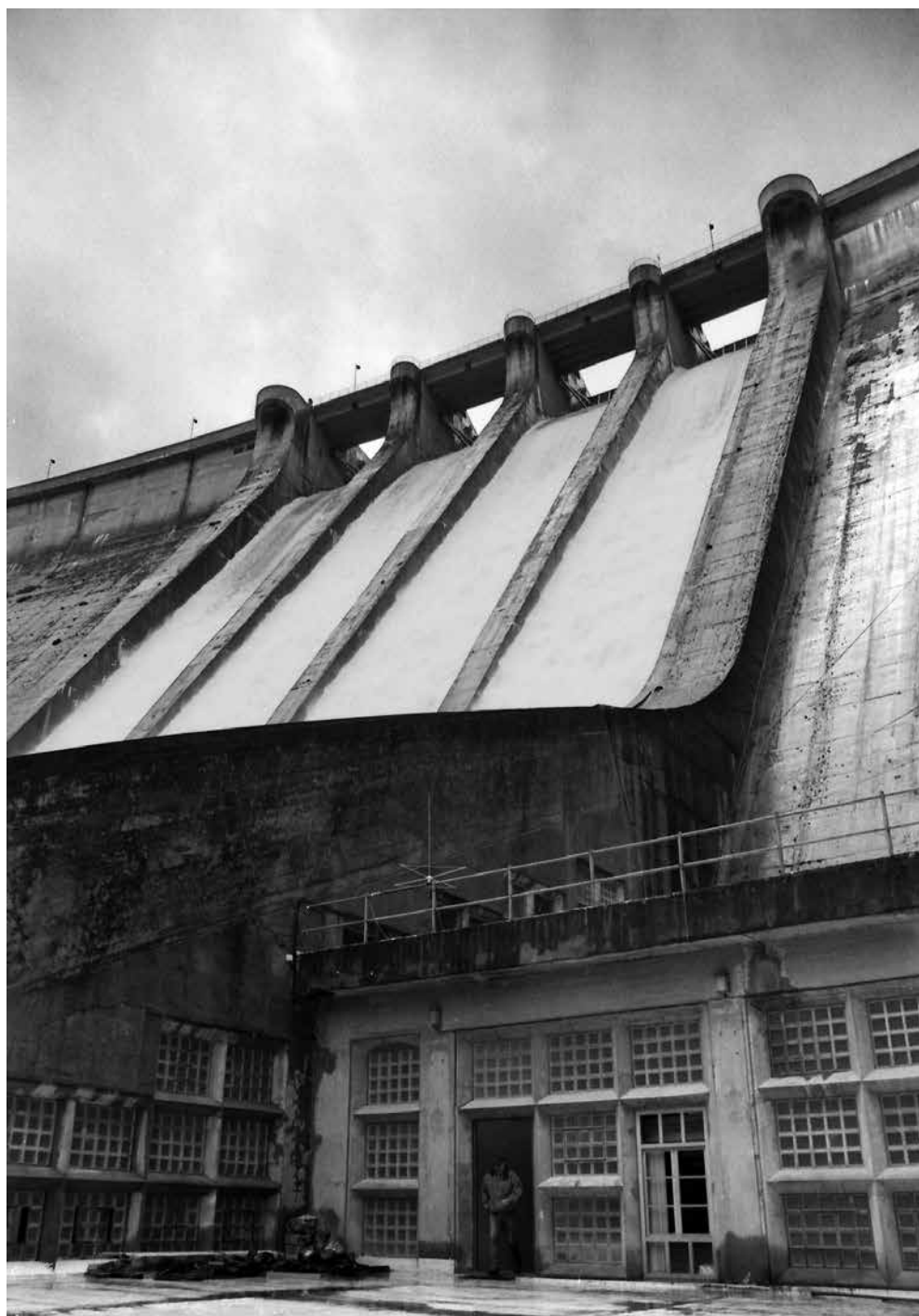
Fig. 3. - Aliviadero en funcionamiento y acceso al interior de la Central, ubicada bajo el mismo. Fotografía de Ángel Sanchís, 2000.
