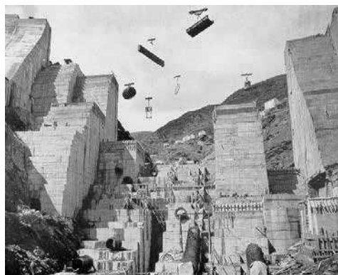
Fig. 2. - Vista de la Presa aguas abajo en la fase de colocación de las tuberías de toma, 1952. Fuente: Saltos del Navia.
