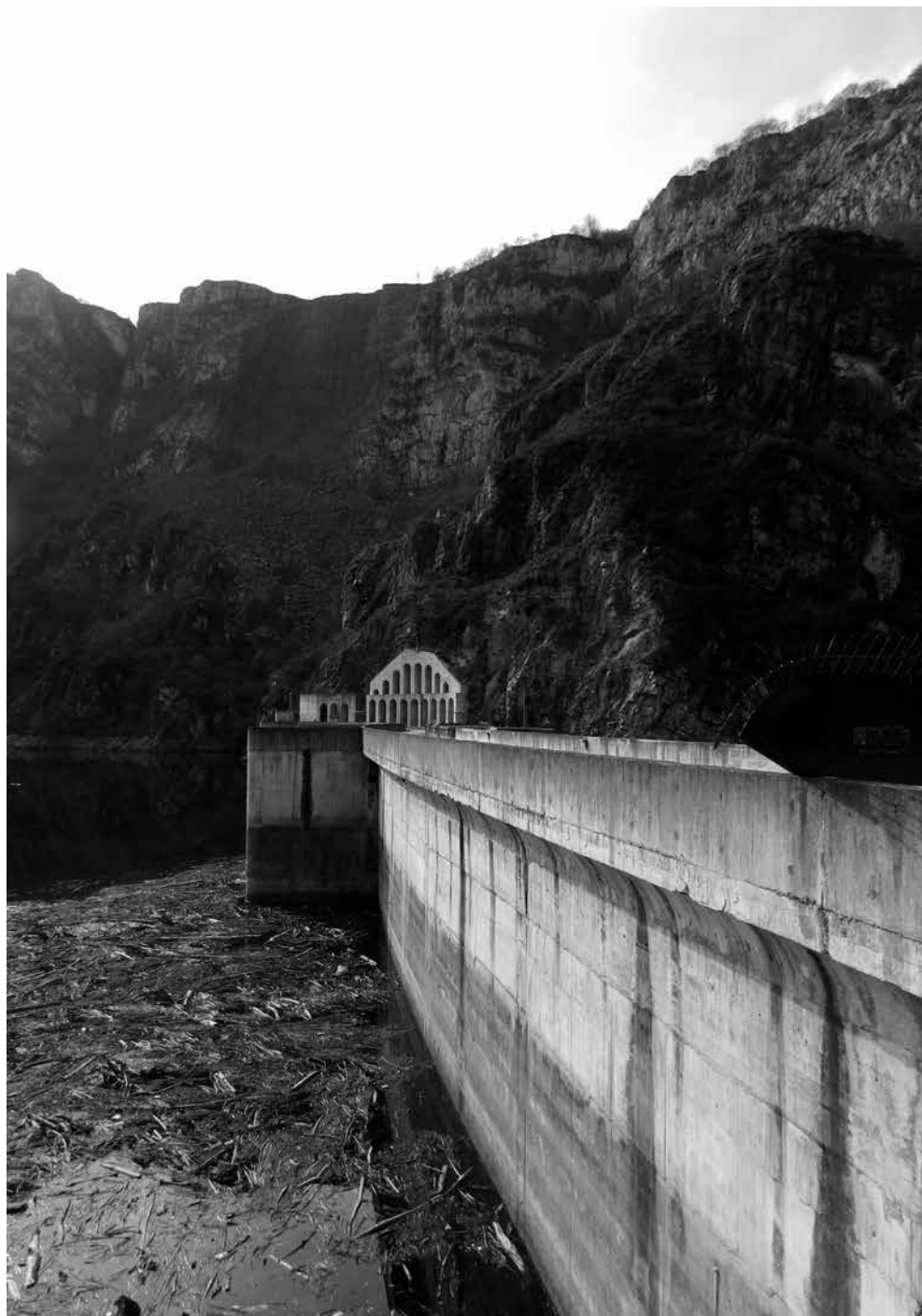
Fig. 16. - Central de Tanes. Fotografía de Manuela Mattone, 2016.
