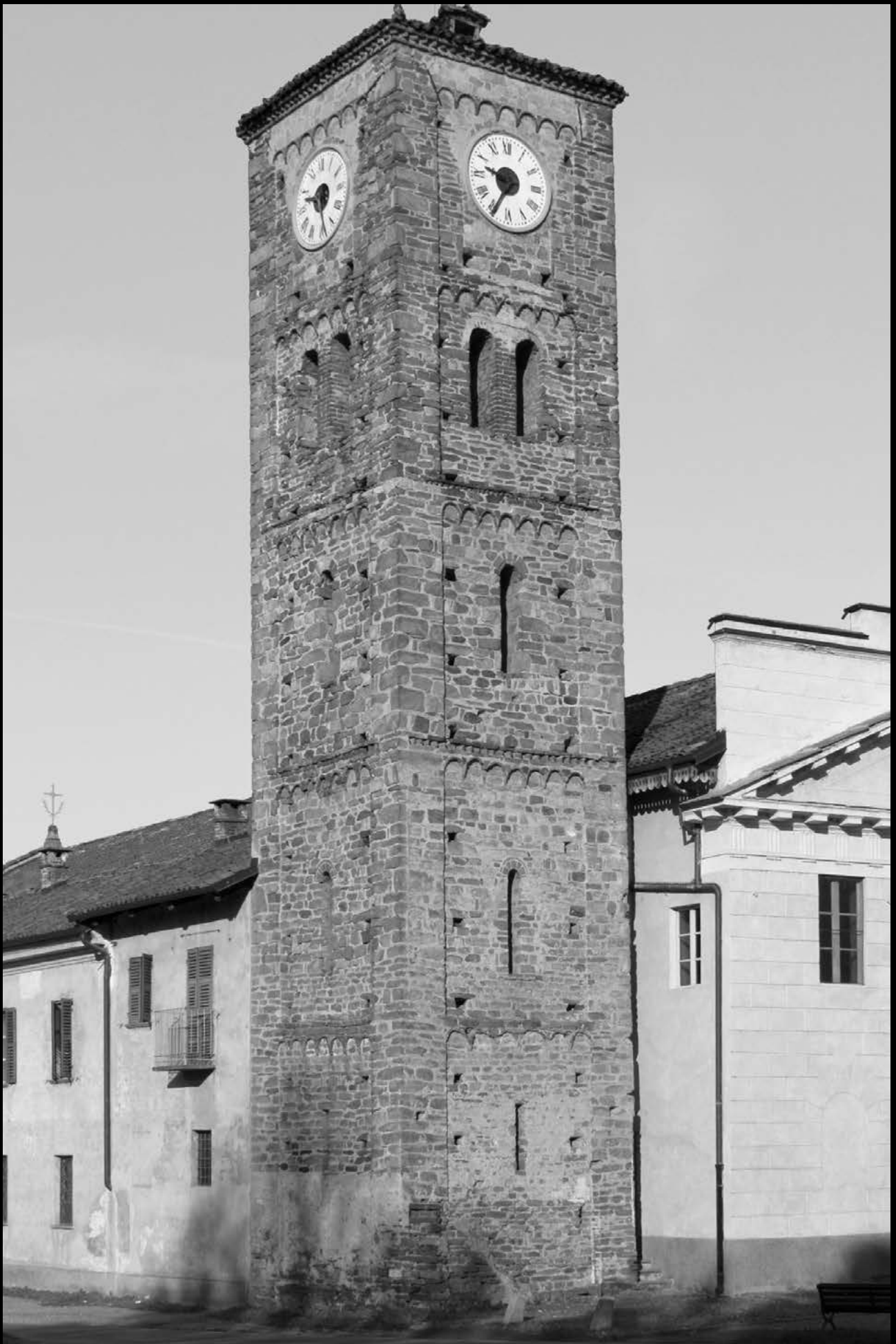
Fig 4 - Il campanile della chiesa di San Martino di Saluzzo (foto S. Beltramo).
