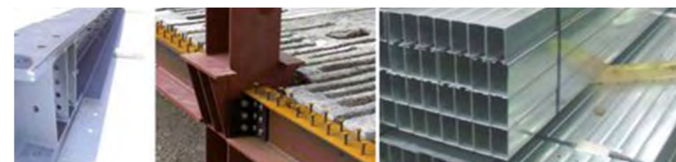
Esempi di profili ricadenti nella EN 1090 - travi composte saldate e profili sottili formati a freddo
