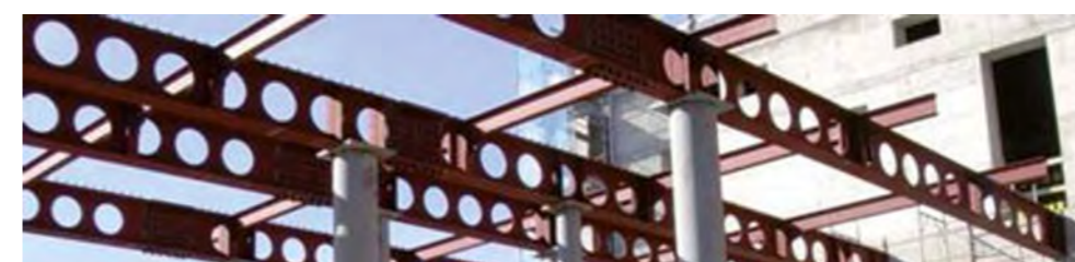
Travi Alveolari in fase di cantiere
