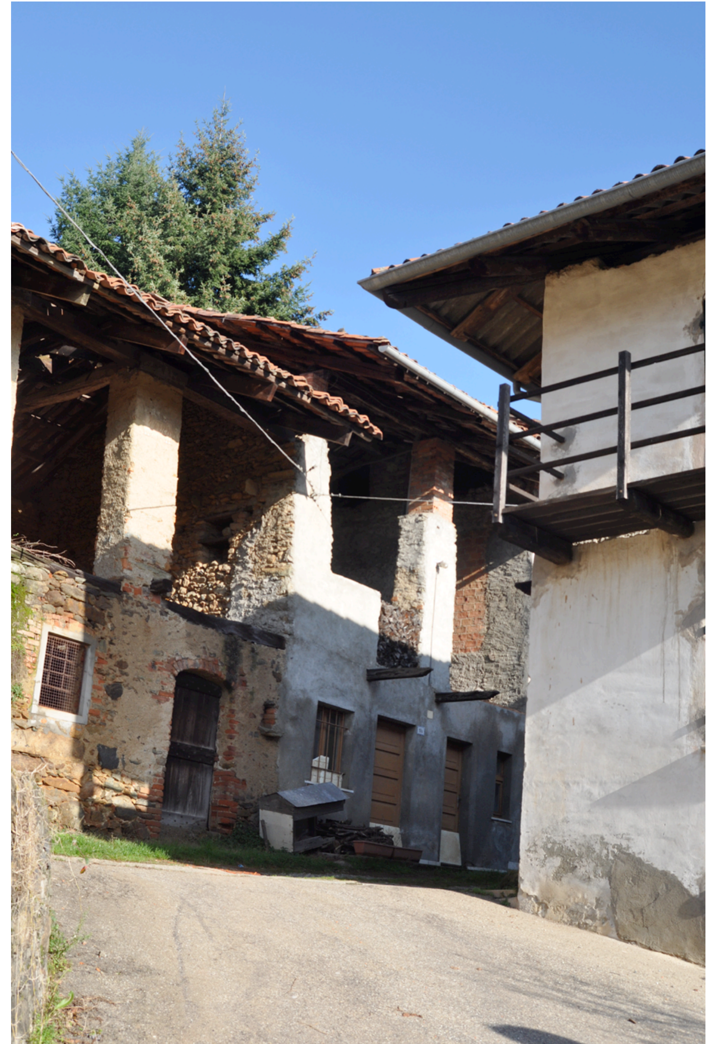
Figg. 20 - 21 - Stato attuale di un altro edificio in frazione Piletta. Il rilievo ne è risultato complesso a causa dei forti dislivelli, degli sbandamenti delle murature e delle coperture, permettendo tuttavia di cogliere gli elementi significativi per proporre soluzioni di recupero.
