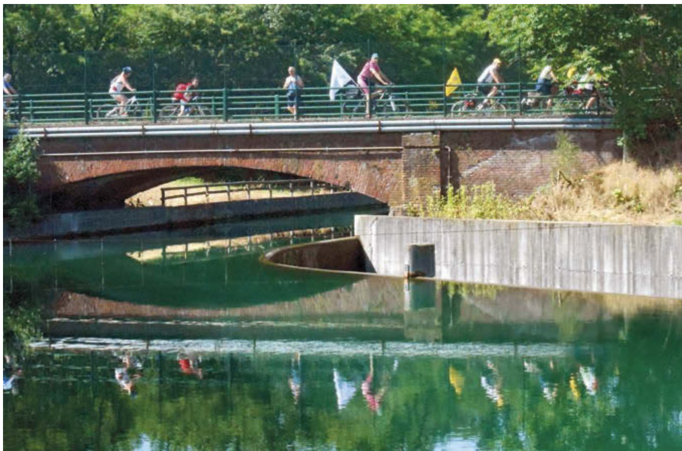
Scaricatore del Canale Cavour a Galliate. Centrale Idroelettrica Dogana.
