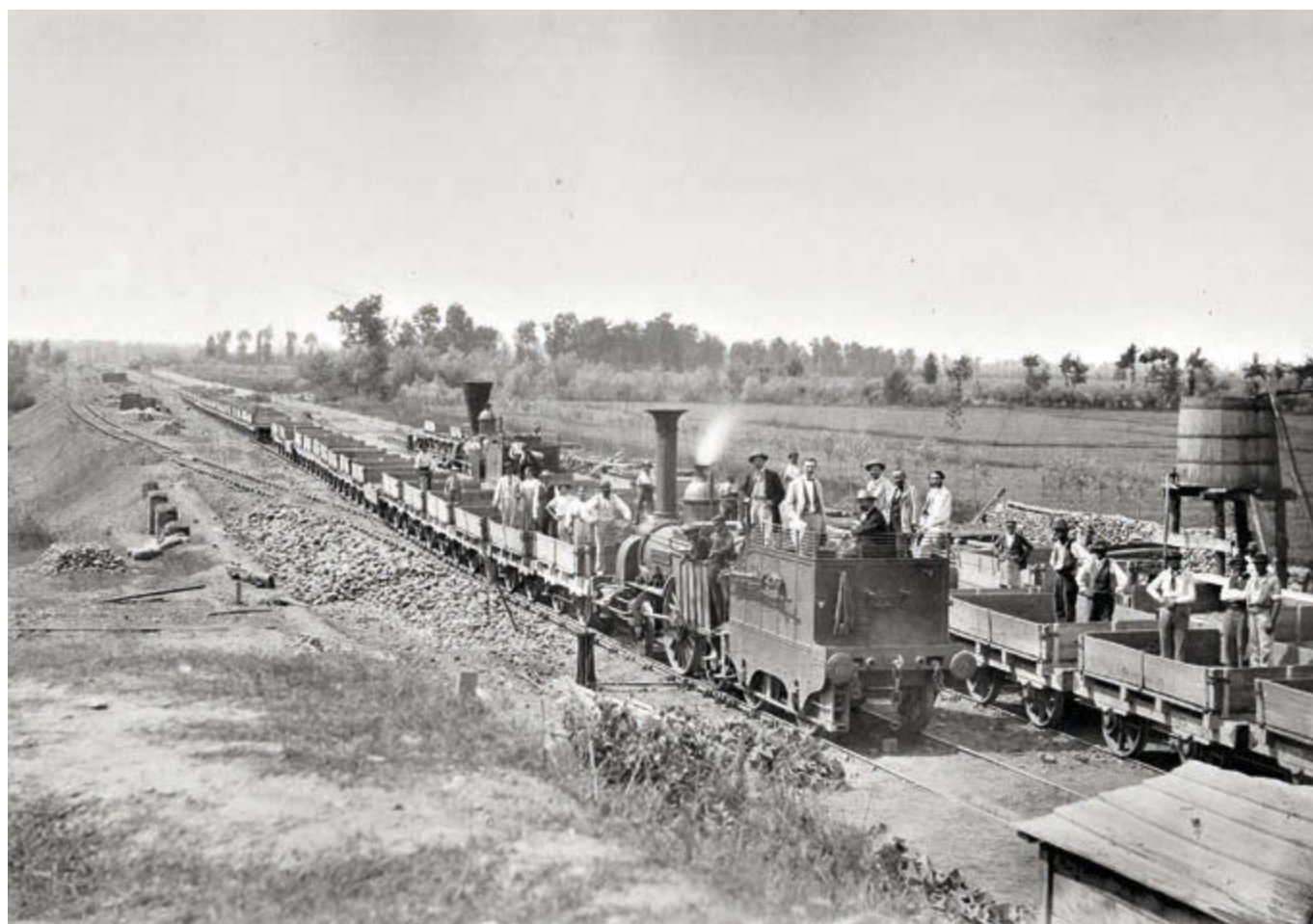
Lavori per la costruzione del Canale Cavour. Fotografia d'epoca dei cantieri.
