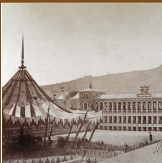
L'inaugurazione del Canale Cavour a Chivasso. Foto d'epoca 1866.
