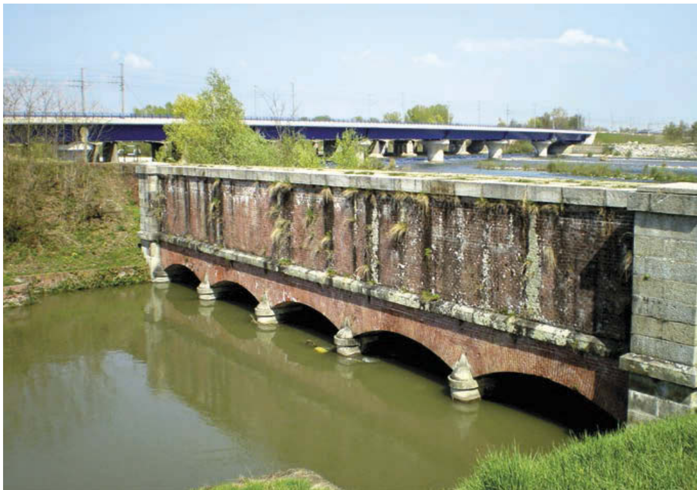
Canale Cavour. Visione attuale dell'imbocco della “Tomba sotto il fiume Sesia”. Sullo sfondo il ponte della linea ferroviaria Alta Capacità Torino-Milano. Foto C. Baratti.
