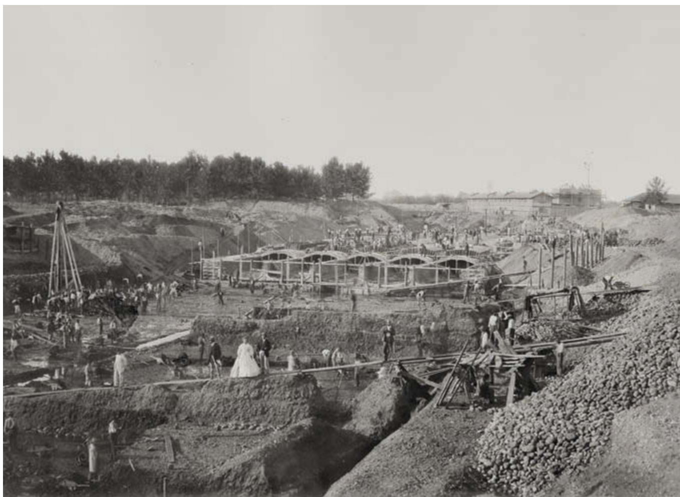
Il Canale Cavour: la "Tomba sotto il torrente Elvo" in costruzione. Al centro una coppia di sposi che si è fatta fotografare nel cantiere. Foto d'epoca.
