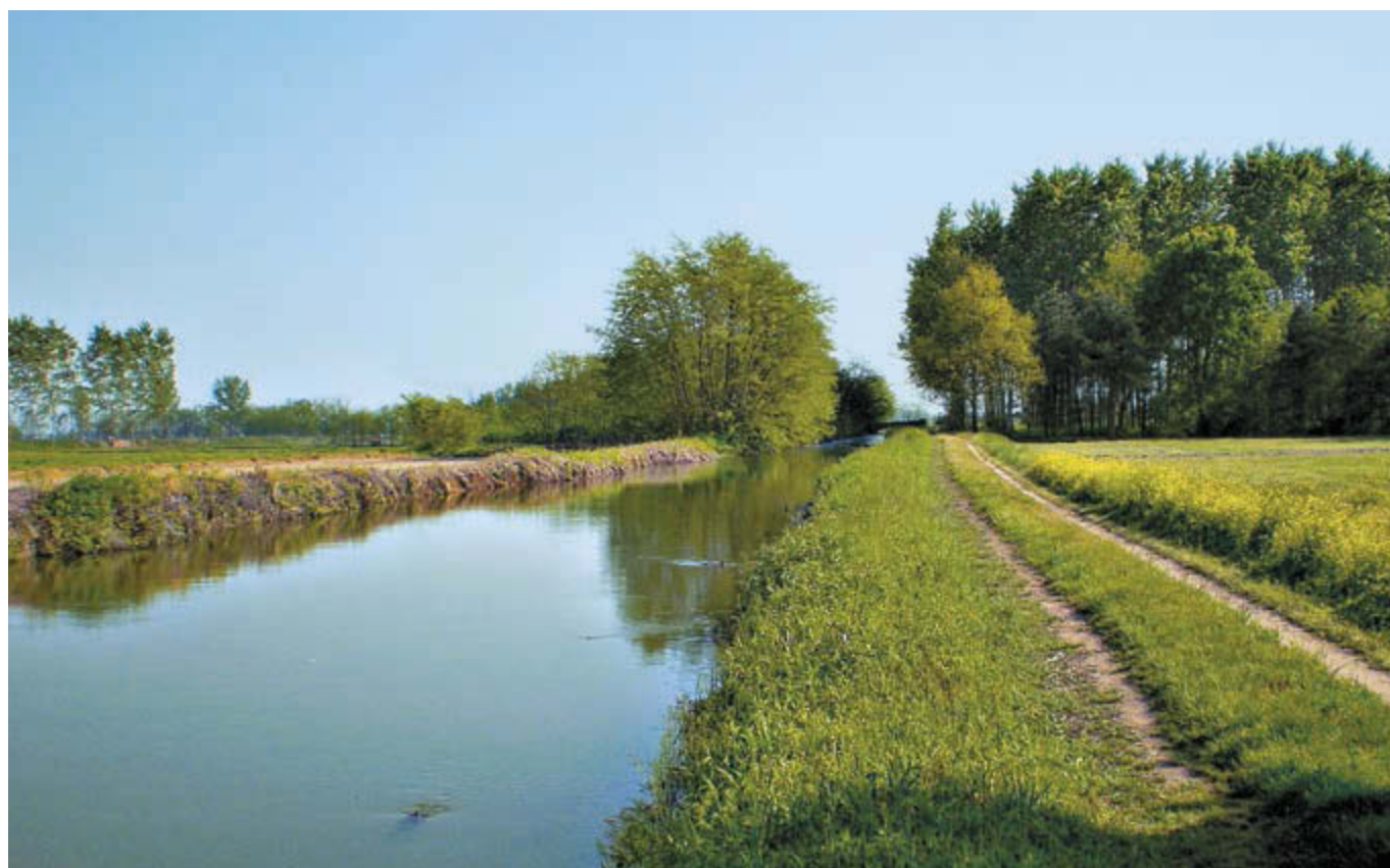
Il subdiramatore Mortara: acqua e natura. Foto C. Baratti.
