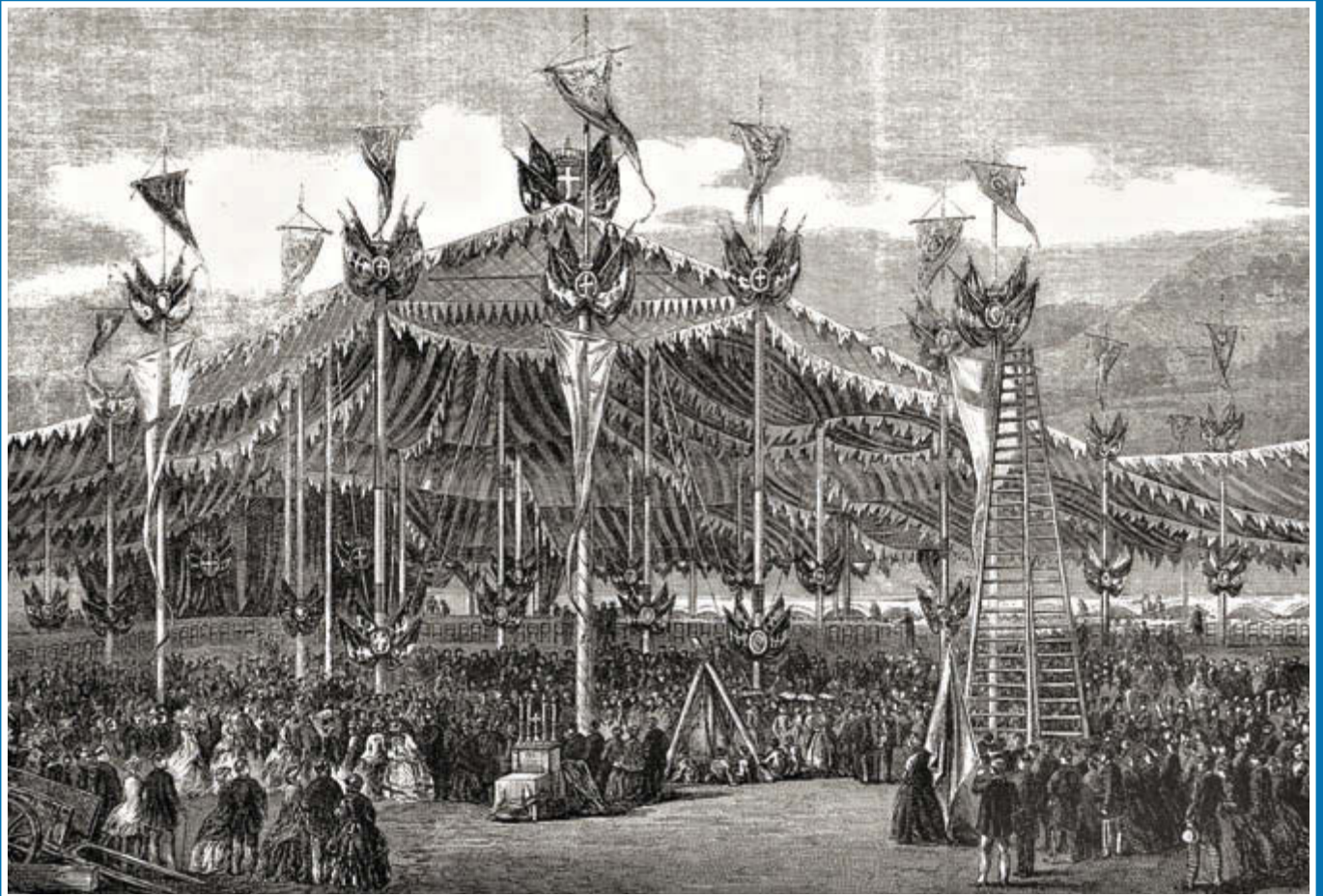
1° giugno 1863. Posa della "pietra fondamentale" del Canale Cavour. Da "The Illustrated London News" , 27 giugno 1863.
