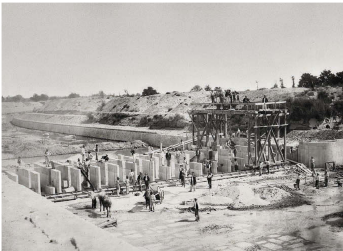
Canale Cavour. Una prima fase dei lavori di costruzione dell'edificio di presa delle acque del fiume Po a Chivasso. Fotografia d'epoca dei cantieri.
