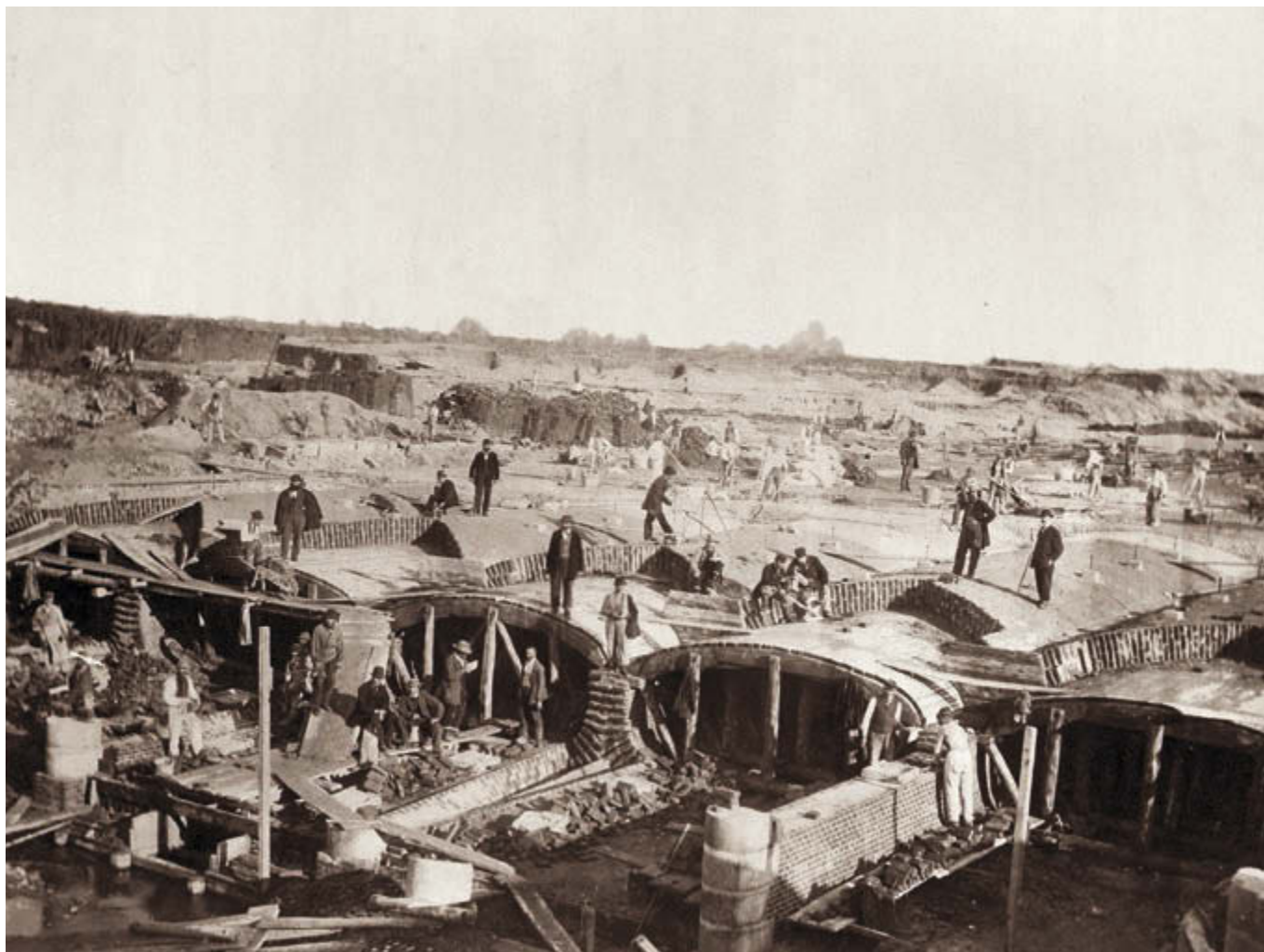
Canale Cavour. Tomba sotto il fiume Sesia. 5 Novembre 1864. Fotografia d'epoca dei cantieri.
