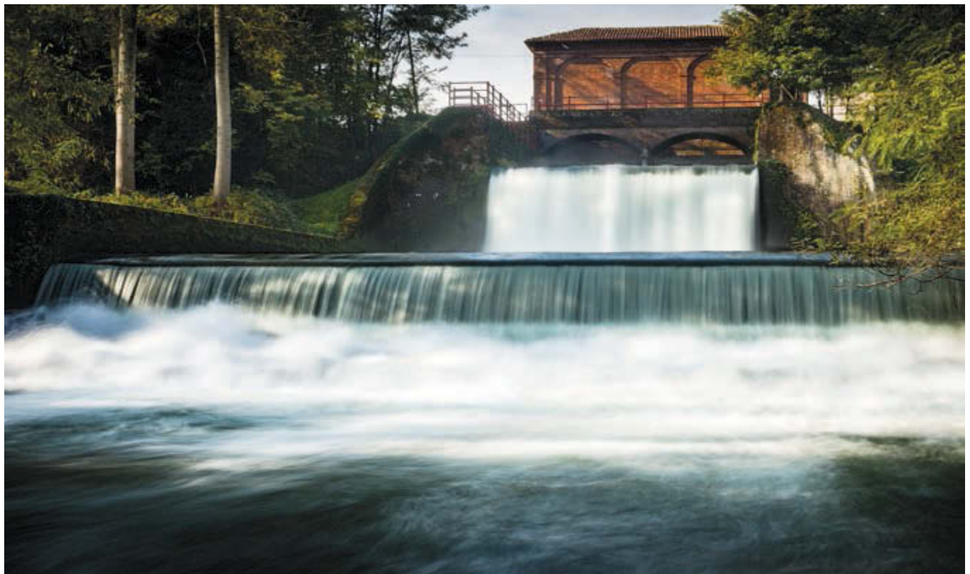
Edificio di scarico del Canale Cavour nel torrente Cervo a Formigliana (VC). Foto di Federico Ranghino.
