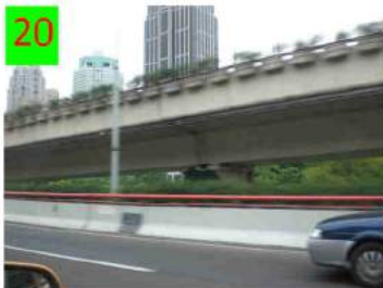
20 Yan'an Road. A destra la carreggiata di immissione dalla North - South elevated Road
