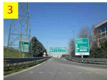
3 Ingresso della Tangenziale sud
