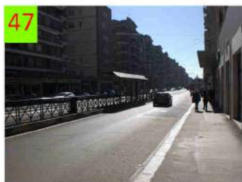
47 Corso Giulio Cesare. I marciapiedi sono ampi ed agevoli.
