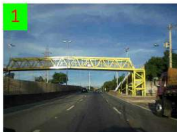
1 Avenida Amazonas nel comune di Contagem
