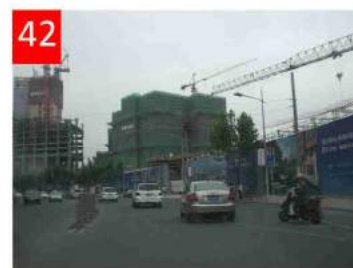
Dongdaming Road. Sul lato destro verso il fiume è stato demolito un cantiere navale e si costruisce un grande centro residenziale
