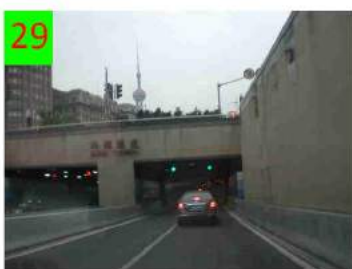
29 Ingresso del Bund Tunnel
