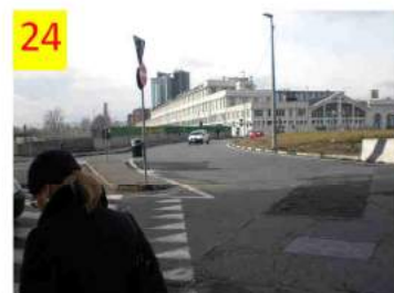
Piazza Baldissera. Gli attraversamenti pedonali sono difficoltosi vista l'assenza di un impianto semaforico.
