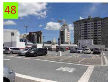
Il tetto del Diamond Mall.
