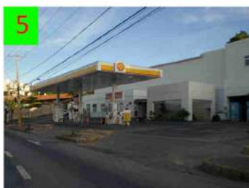
5 Una delle numerose stazioni di rifornimento lungo l'Avenida Amazonas
