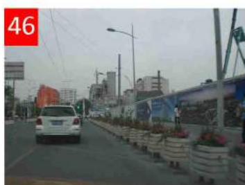
Yangshupu Road. Strada ancora in ristrutturazione per essere allargata
