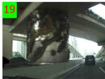
19 Yan'an Road. Il Dragon Pillar che sorregge gli svincoli di intersezione tra le due sopraelevate
