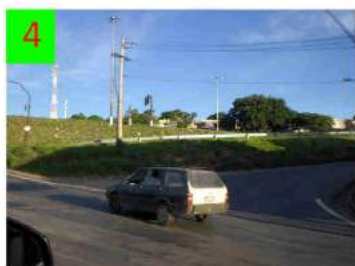
4 Svincolo di immissione dalla Avenida Amazonas per l'Anel Rodoviario
