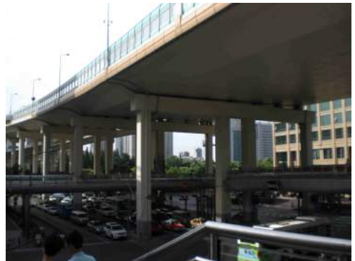
Fig.66. La North-south elevated road. Fotografia dell'autore
