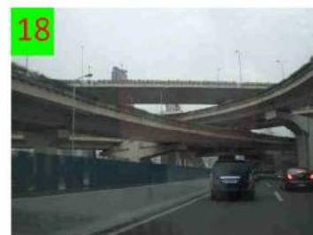
18 Yan'an Elevated Road. Terzo livello dal piano stradale
