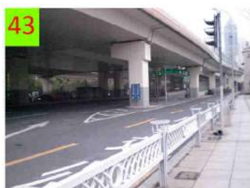
Vista della sopraelevata dai marciapiedi.
