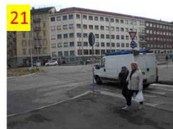
Corso Principe Oddone. L'area di cantiere rende difficoltosi gli attraversamenti pedonali, visto anche l'elevato traffico privo di impianto semaforico.
