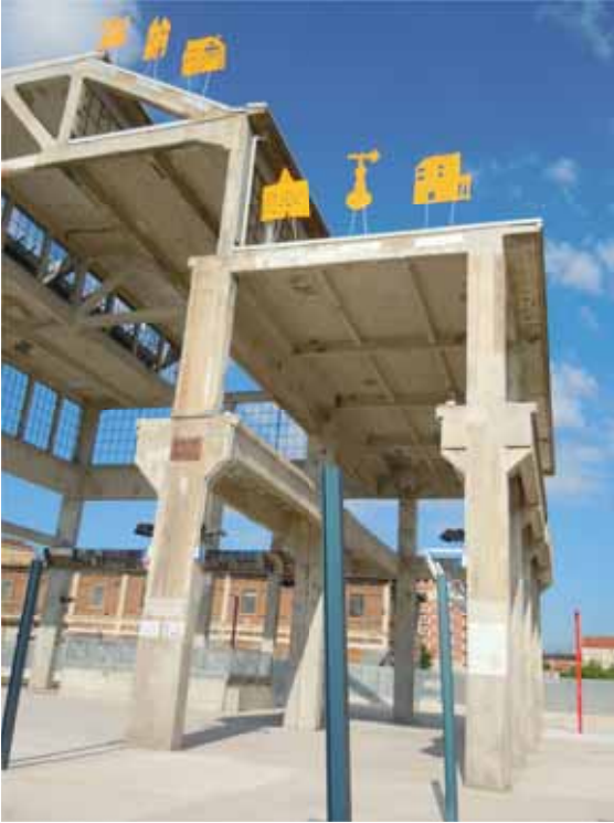
Fig. 3. Parco Aurelio Peccei (Spina 4), Torino, particolare delle opere "Casette della comunità" sui resti dell'edificio industriale degli anni '20. Da un'idea dell'artista Alessandra Belloni, proposto da "Promenade dell'arte e della cultura industriale", le immagini delle "casette" in lamiera sono selezionate attraverso un concorso per le scuole primarie e del preobbligato del quartiere. Il progetto è sviluppato con ITER, Urban Barriera, Città di Torino, 2014.
