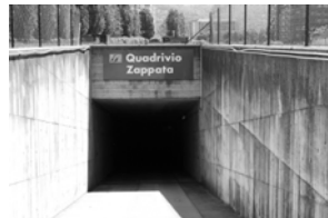
11. Stazione ferroviaria Zappata
