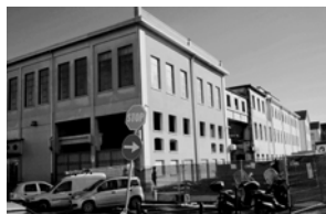
19. Edifici servizi tra vie Cigna e Banfo
