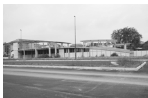
22. Stazione Rebaudengo Fossata
