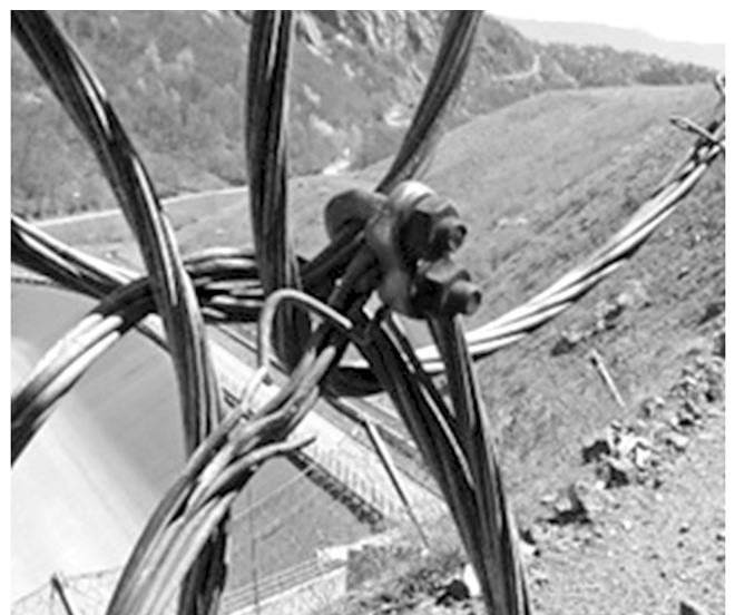
Fig. 13. Esempio di un ripristino di una rete ad anelli tramite l'inserimento di un morsetto, ed il danneggiamento indotto da un impatto successivo all'intervento. Example of a refurbishment of a ring net through the insertion of a clamp and the induce damage due to a subsequent impact.
