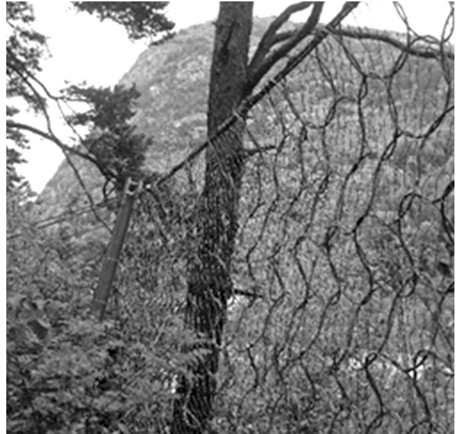
Fig. 12. Particolare di un tronco a ridosso della rete di una barriera paramassi a rete. Detail of a tree close to the rockfall protection net fences.
