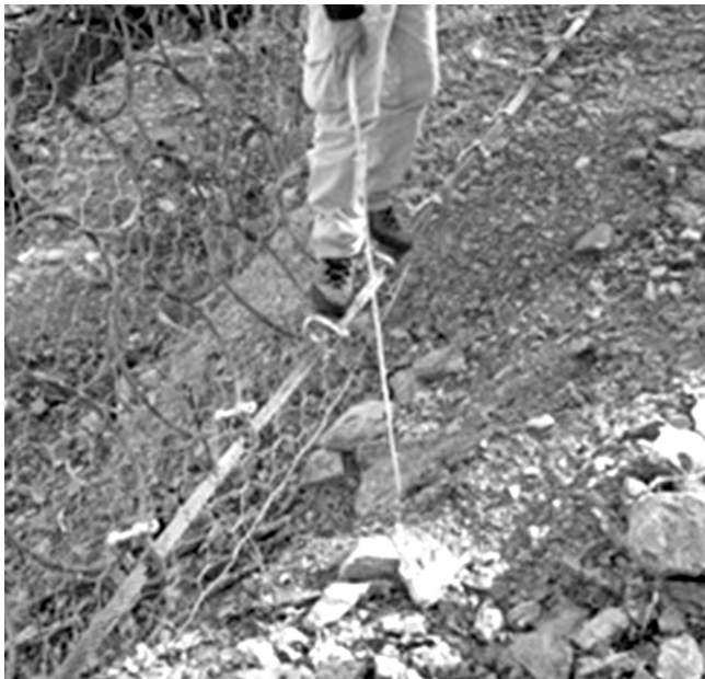
Fig. 8. Esempio di un varco al piede della barriera paramassi a rete.
