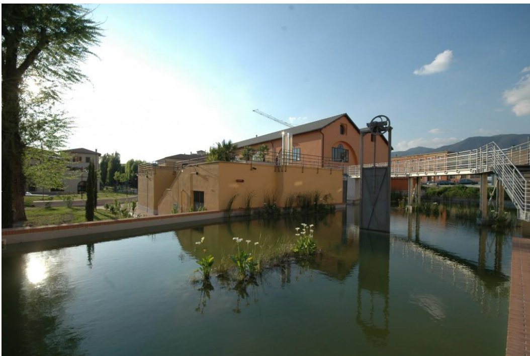
Fig 67 Immagini dopo l'intervento di riqualificazione (FONTE:Sito ufficiale CAOS museum)
