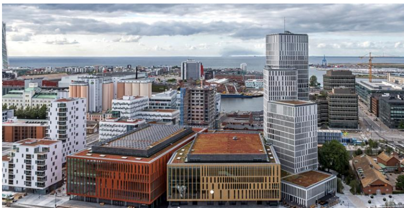
Fig 35 Vista dell’area Malmö Live (FONTE: Sito ufficiale TENGBOOM Architetti)
