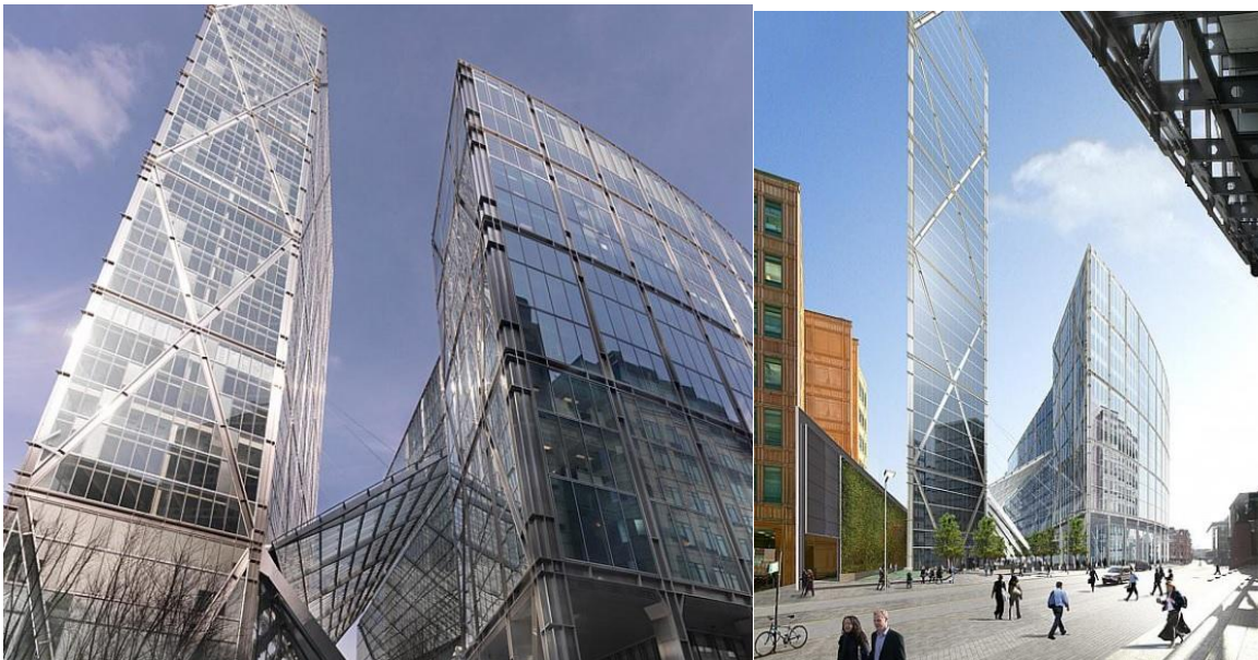
Fig.16 Viste di Bishopsgate e della Broadgate Tower. (Fonte: sito ufficiale studio SOM di Skidmore, Owings & Merrill)
