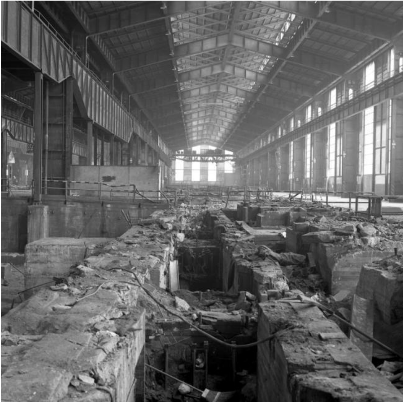
FOTO 28(BB). Alla fine degli anni Sessanta l'estensione dello stabilimento superava il milione di metri quadrati; le difficoltà provocate dell'articolazione in più ambiti venivano risolte sfruttando i numerosi collegamenti resi possibili dalla costruzione di strade carraie, strade ferrate e, dove necessario, passaggi al di sotto del piano di campagna. Lo scatto mostra uno degli stabilimenti durante le fasi di demolizione del basamento in cemento armato.
