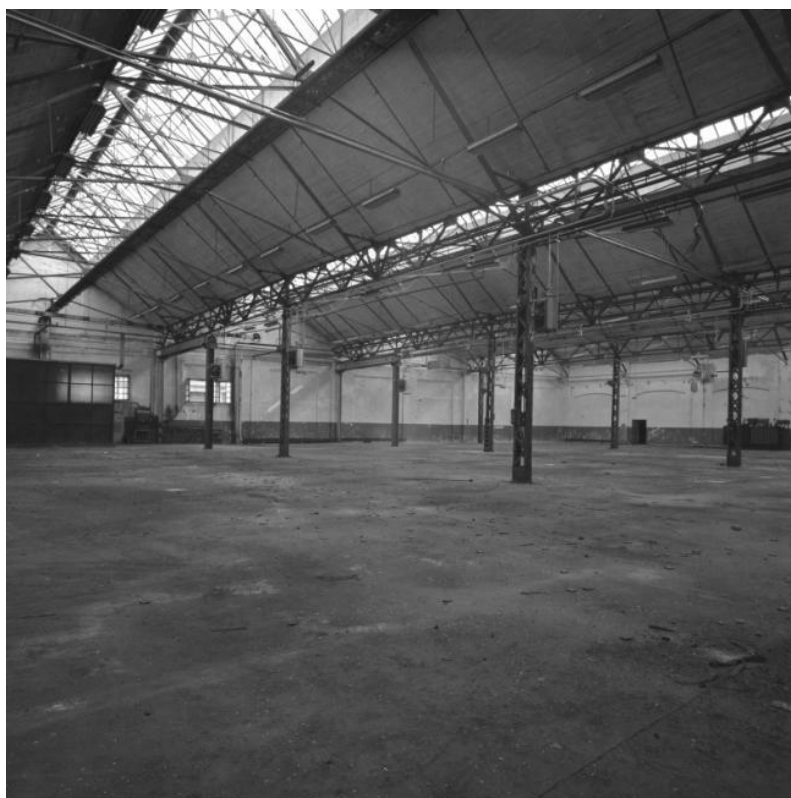
FOTO 17(BB). Il capannone principale era realizzato con struttura mista in muratura e pilastri e travi in acciaio. La copertura a shed permetteva l'illuminazione naturale del grande spazio.
