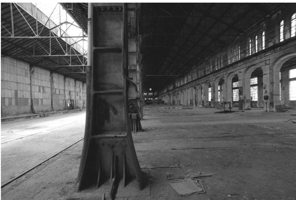
FOTO 23-24(BB). “Gli immani e suggestivi fabbricati che costituiscono il complesso, ciascuno dei quali edificato con tipologie costruttive coerenti con le funzioni a cui erano chiamati a rispondere (...), fanno riflettere sulle complesse lavorazioni a cui era chiamata ad operare la manodopera altamente specializzata che contava, nei periodi migliori, sino a 2.000 operai.” 29
