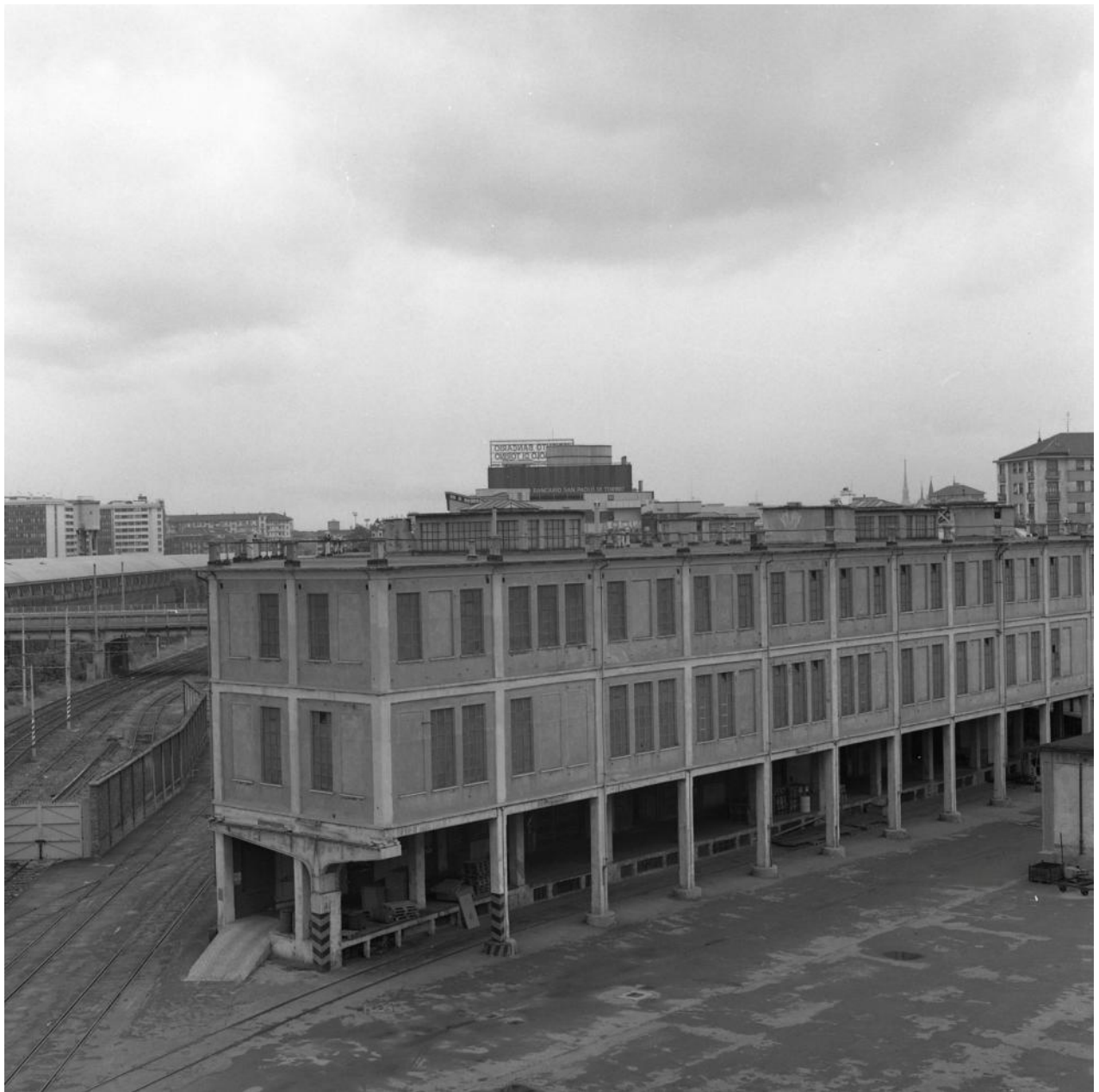
FOTO 6(BB). I Docks Piemontesi furono costruiti nel 1914 ad opera dell'impresa Poercheddu utilizzando il sistema costruttivo Hennebique ed erano destinati allo smistamento ferroviario delle merci.
