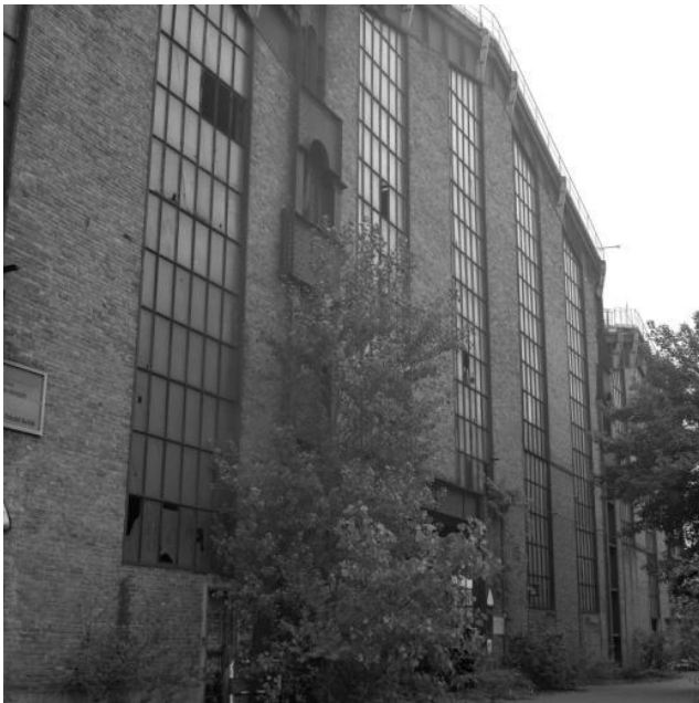
FOTO 25(BB). Gli stabilimenti Teksid erano un tipico esempio di edilizia industriale realizzata in cemento armato e ferro negli anni Venti del secolo scorso.
