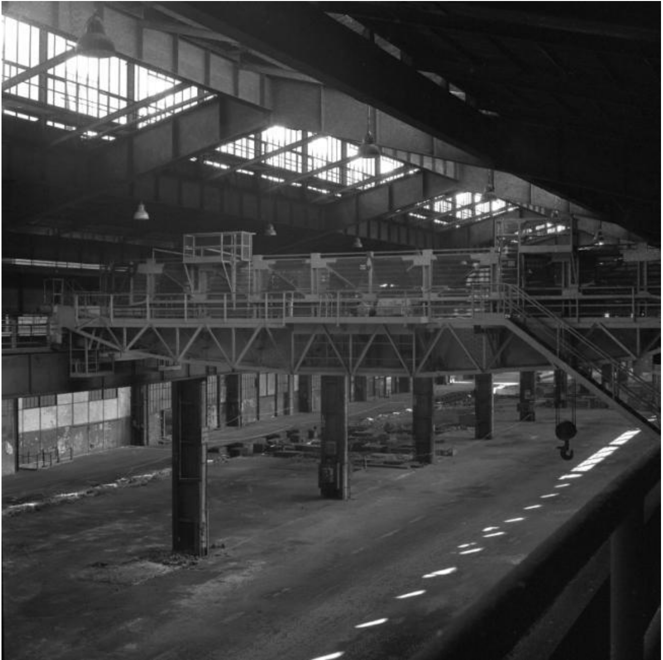
FOTO 29(BB) Gli imponenti capannoni lungo via Nole, realizzati in carpenteria metallica e muratura, coperti e tamponati, appartenevano al comprensorio Ingest (dal nome della controllata Fiat che vi operava). Dagli anni Trenta in avanti all'interno dello stabilimento venivano prodotti nastri di lamiera facendo giungere i lingotti necessari dalla vicina area Vitali, utilizzando vagoni ferroviari che viaggiavano nei sottopassi presenti nell'area.
