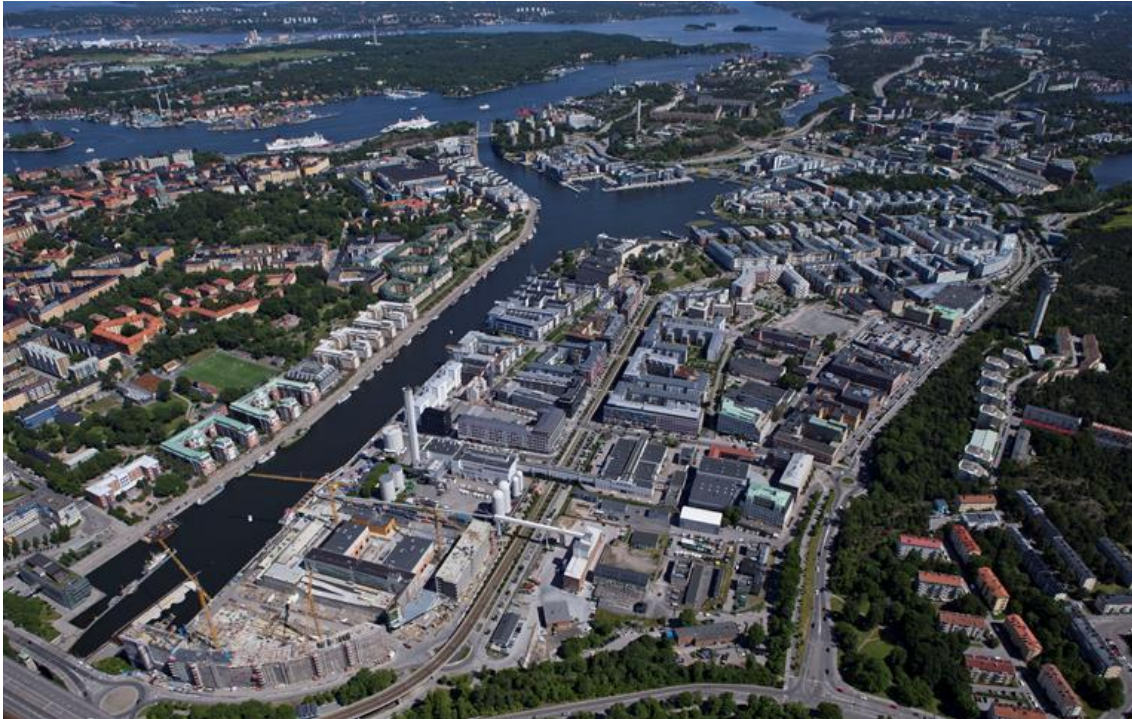
Fig 42 Vista aerea dell'intervento di riqualificazione urbana (FONTE: sito ufficiale della città di Stoccolma)
