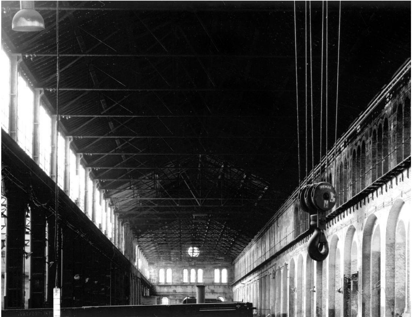
FOTO 6(BB). La straordinaria spazialità e la leggerezza delle strutture ove ogni elemento, sia pilastro che trave, assolve alla duplice funzione di appoggi per i grandi e luminosi shed in copertura e di sostegno per carri ponte che movimentavano gli eccezionali carichi di vagoni e locomotive i cui componenti venivano torniti ed eseguiti all'interno della fabbrica. “La capacità produttiva annua della fabbrica era di 165 locomotive e 15.500 vagoni, e dava lavoro a 2.000 operai” 28
