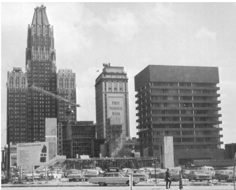
Fig 3 Immagine della Costruzione del Charles Center nel 1967 (FONTE: www.kilduffs.com )
