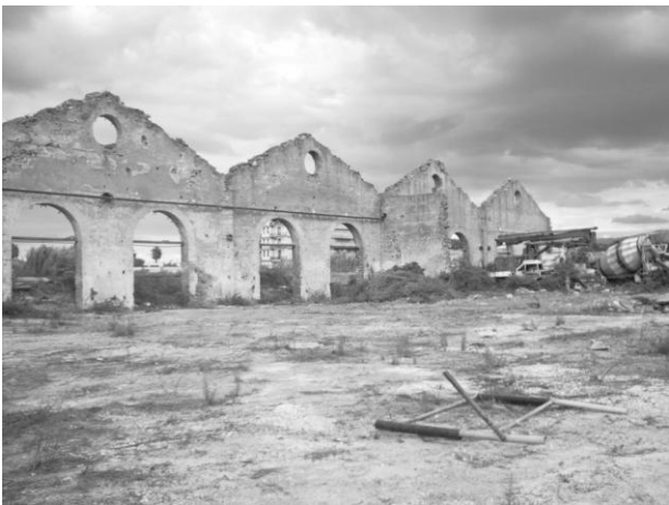
Fig. 1 . Milazzo (ME), Ex Montacatini Terme. Modularità e serialità in ciò che rimane delle facciate esterne dell'ex stabilimento industriale. (Fonte: foto dell'A., 2009)
