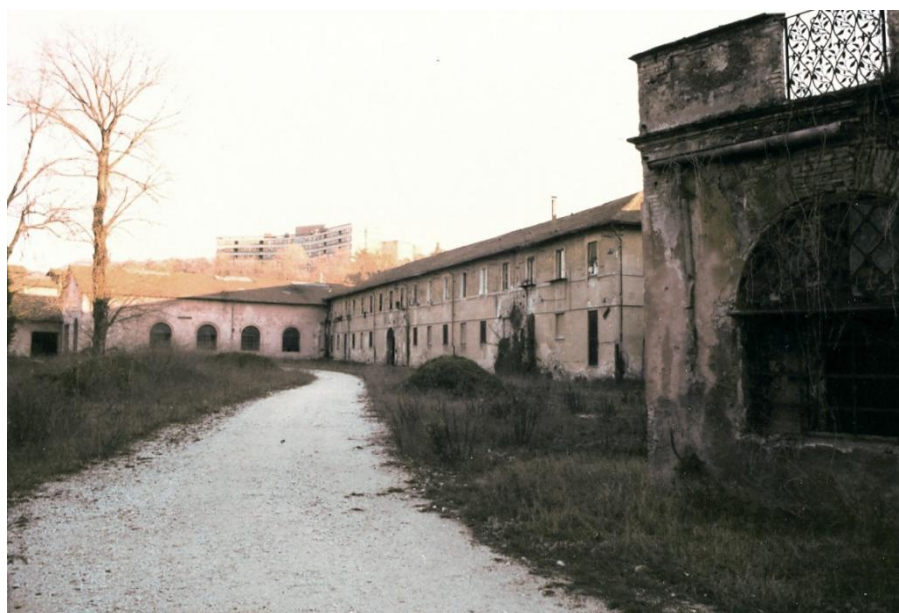
Fig. 65 Immagini delle preesistenze prima dell'inizio dell'intervento di riqualificazione (FONTE: Sito ufficiale CAOS museum)
