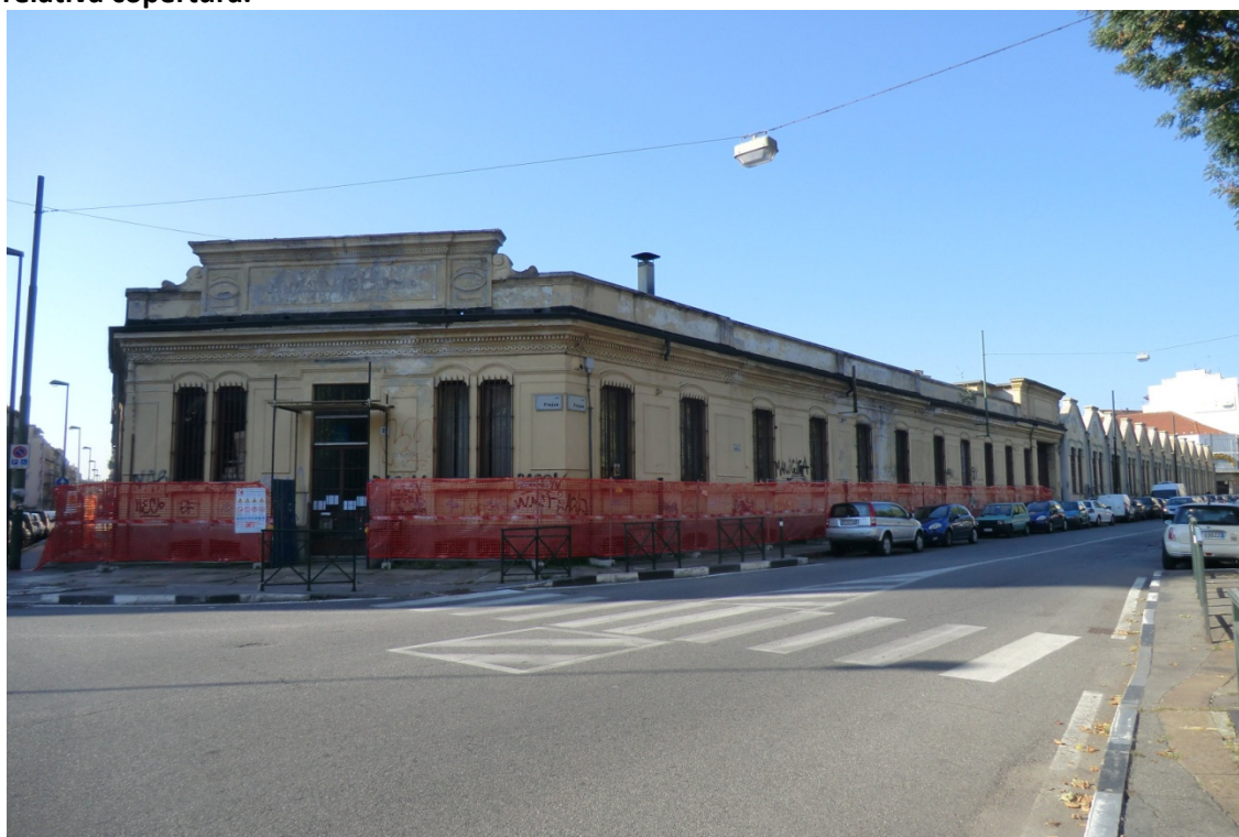
Figura 3. Vista dell'area Diatto – Snia Viscosa al termine delle demolizioni dall'angolo tra via Cesana e via Moretta. Si può osservare il mantenimento del muro perimetrale e della relativa copertura.
