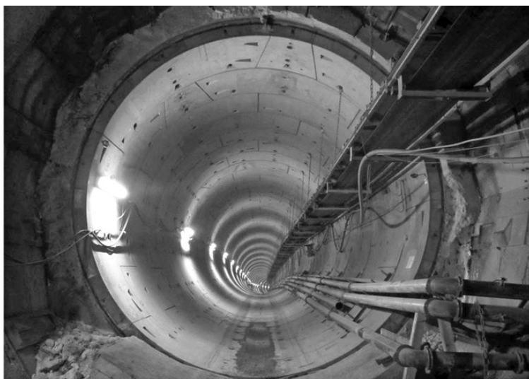
Fig. 3. View of the hardened grout as can be seen in the enlargement for a station in Prague Metro (photos Mapei's archive). Vista della miscela indurita a tergo dei concetti come visibile nell'allargamento di una stazione nella metropolitana di Praga (fotografia archivio Mapei).
