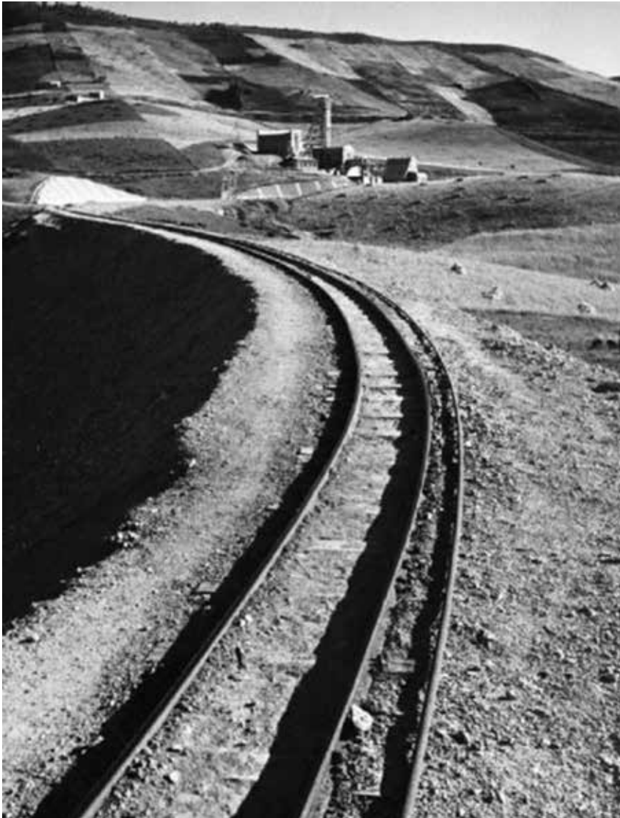
Fig. 1: Grottacalda Sulphur Mine (1940). Railway and Headgear Structure. Ufficio Fotografico Montecatini. Available from: http://www.lombardiabeniculturali.it/fotografie/schede/IMM-3h030-0001006/ . [ Accessed: 09th April 2015].
