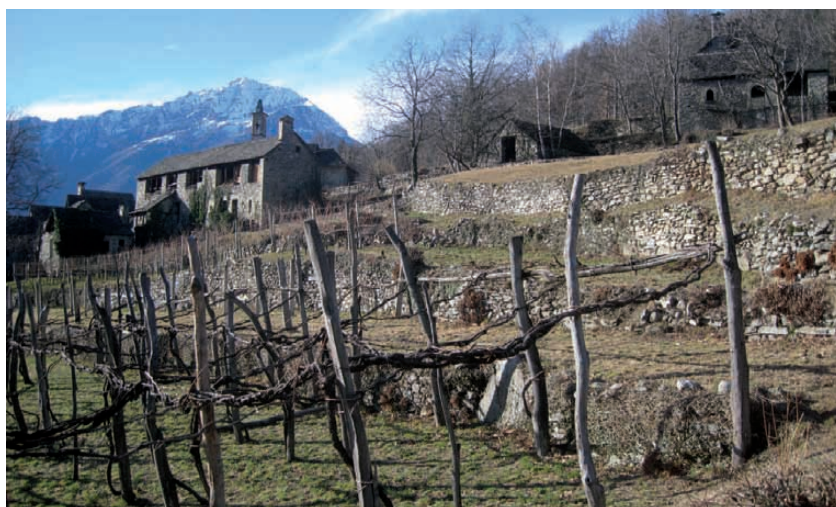
Fig. 2.2-50 - Vista di parte del sistema terrazzato circostante la borgata Naviledo nel comune di Montecrestese, caratterizzato da un buono stato di conservazione degli elementi costruttivi del terrazzamento e dalla persistenza della tradizionale coltura della vite.
