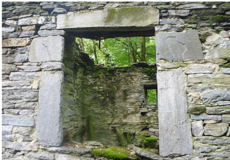
FIGURA 5: Dettaglio della "long house" di Ghesc, 2013. Foto di Andrea Bocco.
