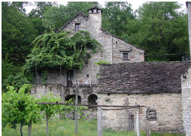
FIGURA 4: Una casa di Alteno (comune di Montecrestese), restaurata da Ken Margardt Foto di Valeria Rossetti, da Bocco, Cavaglià, 2005.
