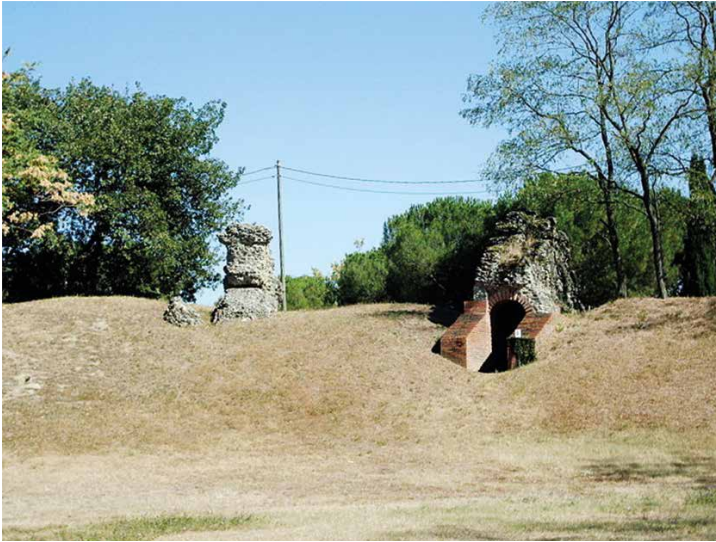
Fig. 15 L'anfiteatro di Tolosa ben identificabile nella sua forma planimetrica, sebbene le strutture necessitino interventi di manutenzione e consolidamento, Toulouse
