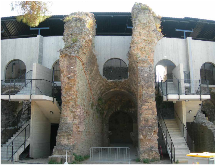
Fig. 5 L'anfiteatro di Forum Julii in cui gli ultimi interventi di "restauro" hanno distrutto il rudere inglobandolo in strutture in calcestruzzo armato, Fréjus
