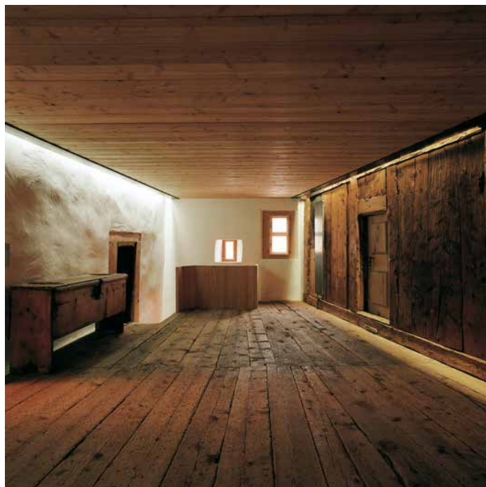
Pareti realizzati con legni antichi recuperati e finitura d'intonaco, Ruch & Partner, Chesa Andrea (fotografia di Filippo Simonetti).
