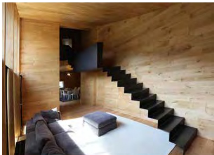
Scala a sbalzo in struttura metallica piegata e incastrata nel muro, architetto Dario Castellino.
