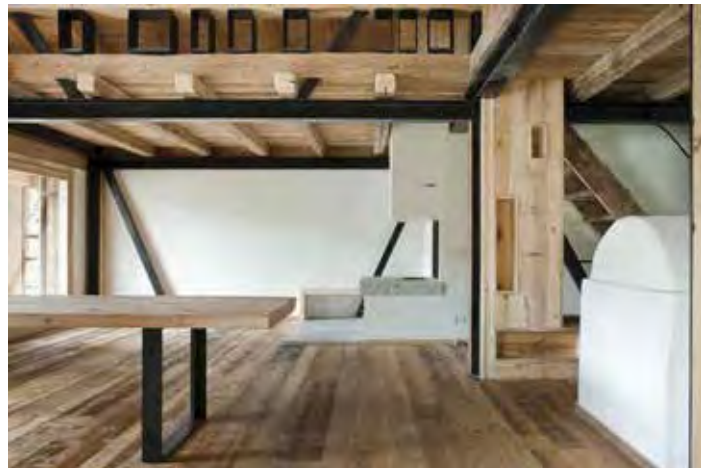
Selva di Cadore, Belluno. Recupero di un Tabià, 2010, Exit architetti (fotografia di Teresa Cos).
