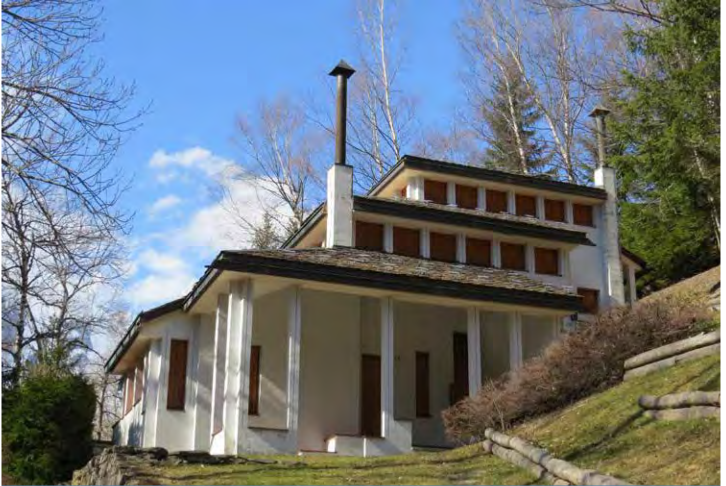
Pussey (Courmayeur), villa Treves (P. Derossi, G. Ceretti, 1967-1970).
