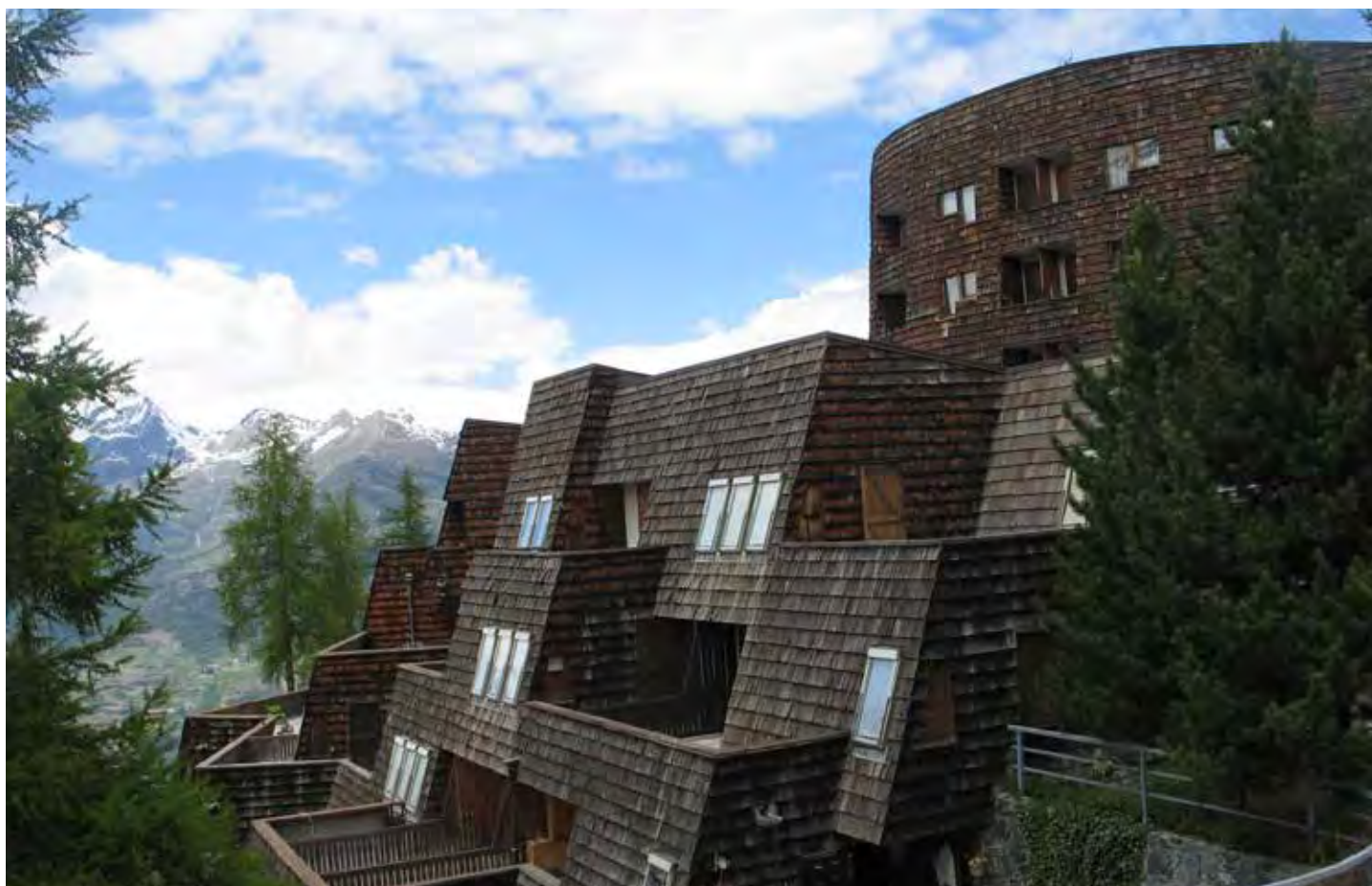
Pila (Gressan), complesso residenziale Plein Soleil (F. Cometto, R. Coquillard, G.B. Debernardi, G. Nebbia, 1976).
