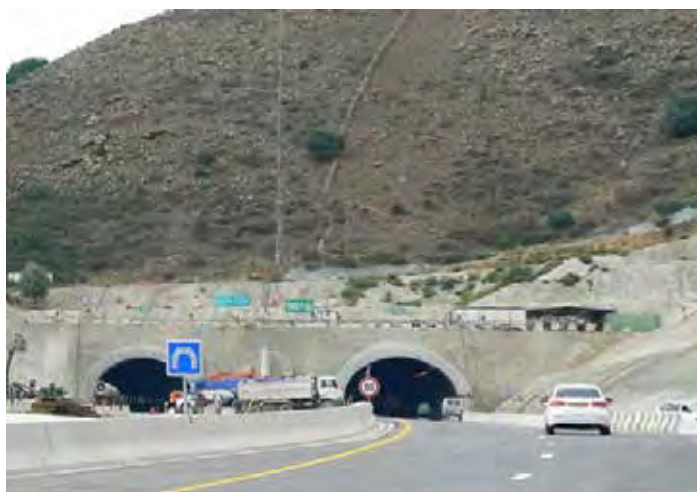
Tunnel de Djebel el Wahch sur le tronçon Constantine-SkikdaConstantine-Skikda.
