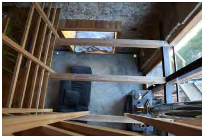
Trasformazione di un vecchio fienile di montagna. La pavimentazione del piano terra è realizzata in cemento spatolato, architetto Dario Castellino.
