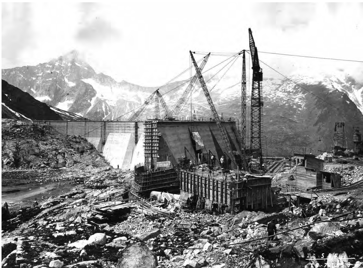
Diga Venerocolo in costruzione (1958).
