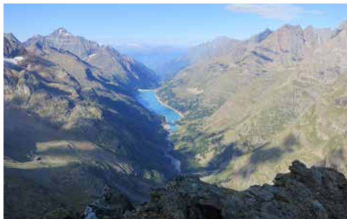
Vista sulla diga di Place Moulin (Bionaz).
