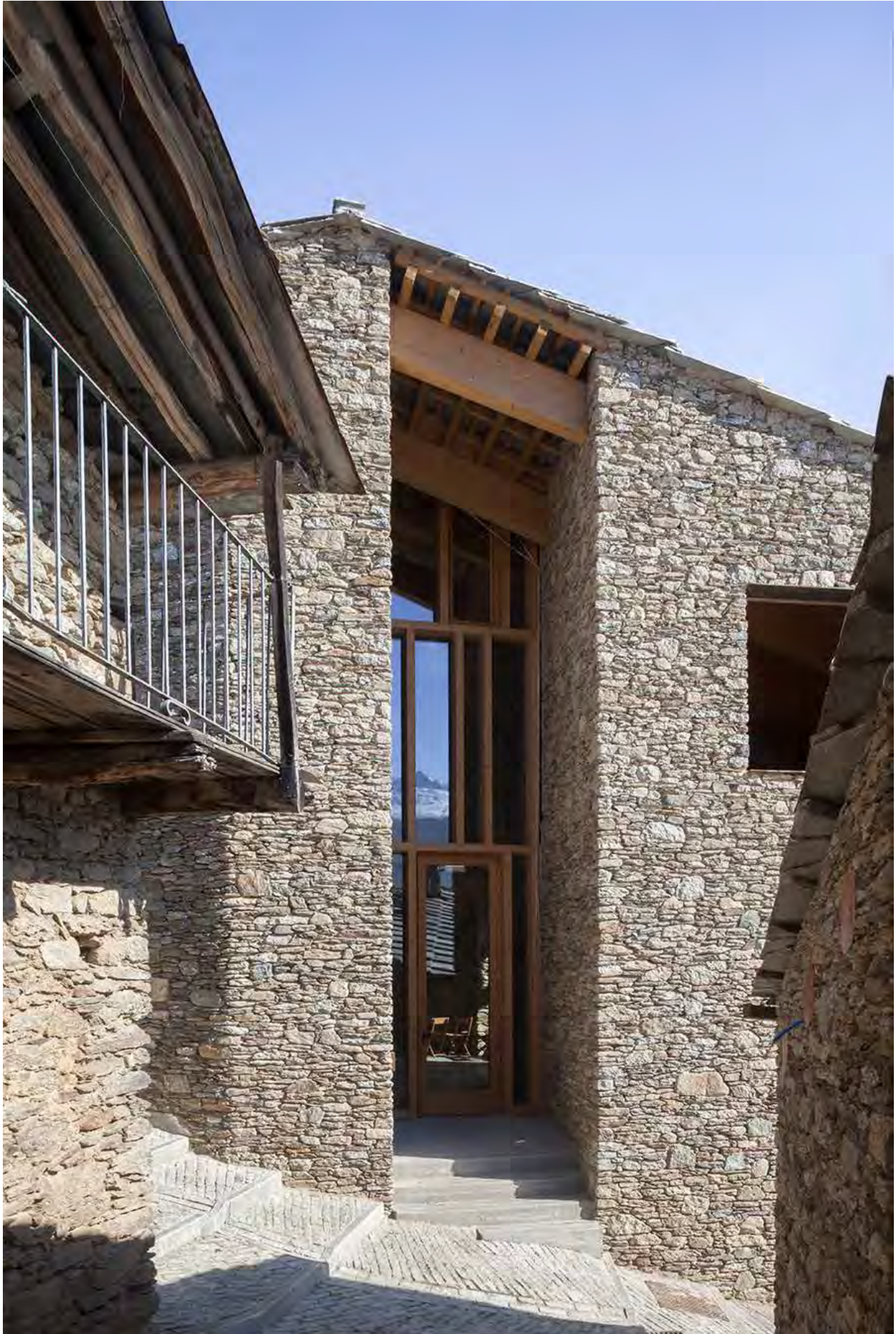
L'asse d'ingresso del centro che attraversa e distribuisce tutto l'edificio (fotografia di Laura Cantarella).
