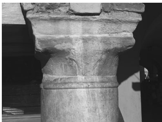
Demonte, via Martiri e Caduti per la Libertà, nr. civ. 1. Palazzo Bolleris.
