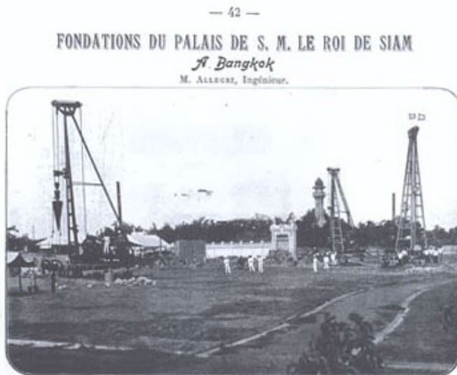
FIG. 45. — Vue générale du chantier.
