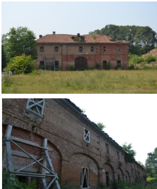
Figure 4 e 5 Prospetti Est (sin) e Nord (ds) del palazzo di Cavalleria Fonte: campagna di rilievo fotografico delle autrici (Settembre - Ottobre 2013)
