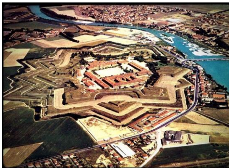
Figura 1 Veduta aerea della Cittadella di Alessandria ( http://blog.fondoambiente.it/alessandria/photogallery )
