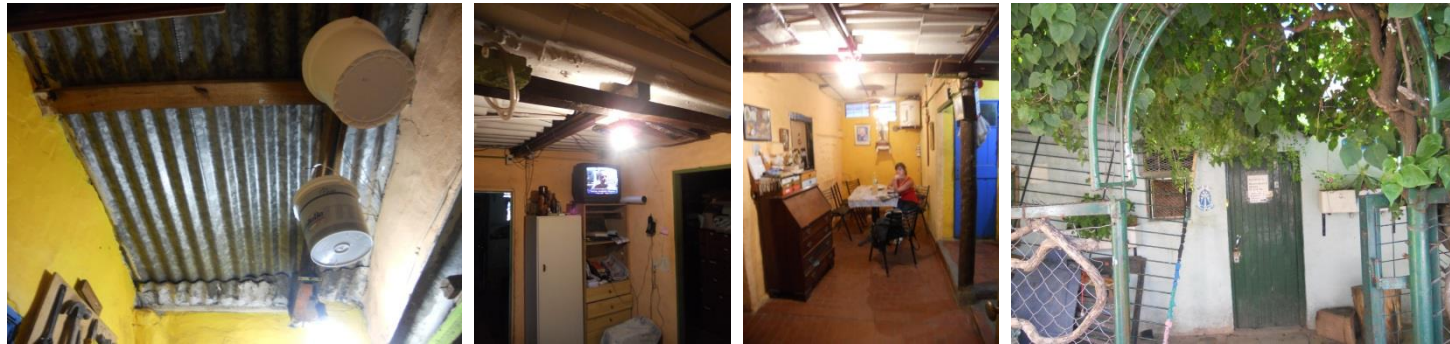
Casa Pipi. Relevamiento realizado en febrero 2012. La casa se encuentra actualmente demolida (21-02-2012).
