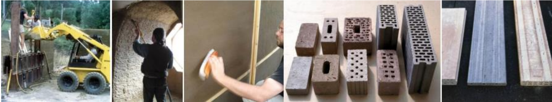
Técnicas con maquinarias especializadas y producción industrializada de productos. Relleno de tapial con maquinaria pesada, revoques proyectados, bloques y losetas industrializadas.
