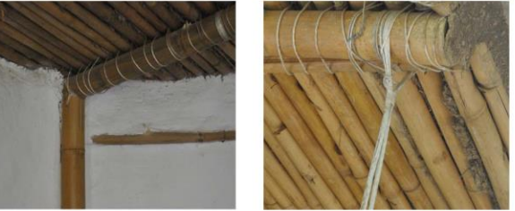
Izquierda: detalle de las columnas interiores. Mientras que una permanece embutida en el muro, la otra se mantiene en el exterior. Derecha: Detalle de tensor que anclado al piso, mantiene la forma curva de las vigas.
