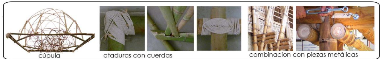
componentes de la estructura : autoproducción + elementos realizados en talleres locales
