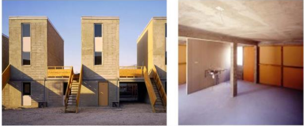
Fachadas e interior vivienda planta baja recién terminadas. fuente: www.elementalchile.cl
