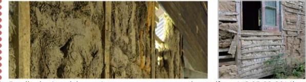
Detalle chorizos del muro interno y estructura envolvente (fotos I. G 05-02-2014).
