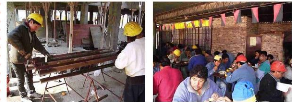
Mujeres trabajando en los talleres de la obra y comedor personal. fuente: http://www.worldhabitatawards.org/winners-and-finalists
