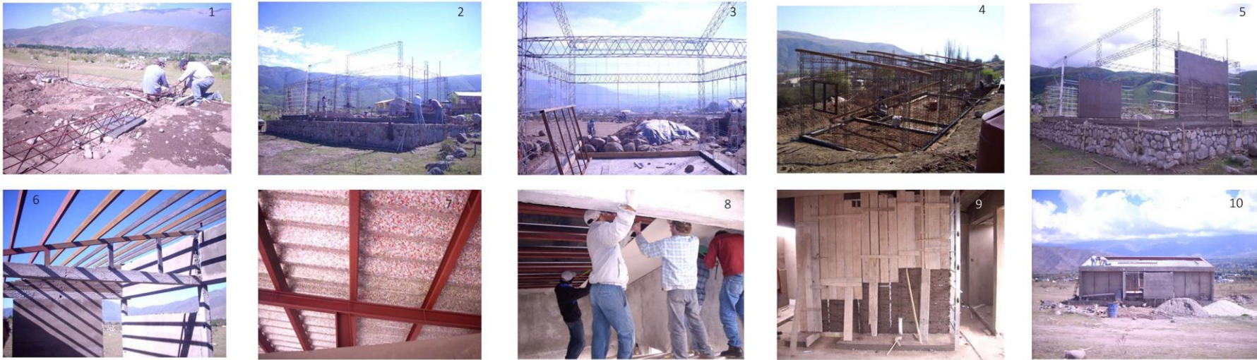
Proceso constructivo. En las fotos 1 a 4, se aprecia el montaje de la estructura metálica. Foto 5: relleno de los muros con tierra local. Fotos 6 a 8: montaje cubierta y ciellorraso. Foto 9: relleno con barro de la estructura en acero galvanizado interior. Foto 10: Realización de techo verde sobre prototipo terminado. fuente: Gentilizada de los autores. Fuente bibliográfica: GATTI, MIRKIN 2010.
