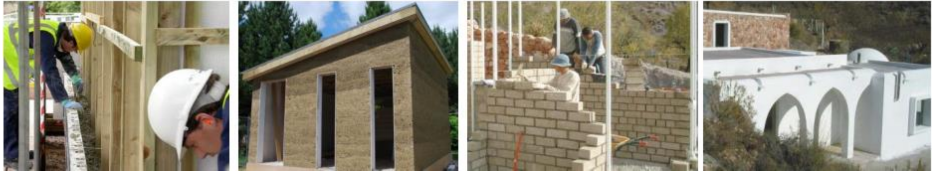
Experimentación con cáñamo. Izquierda: Modulo experimental desarrollado por la Universidad de Bath (fuente Walker 2013). Derecha, vivienda en Granada realizada por la empresa Cannabric (fuente Brummer 2006)
