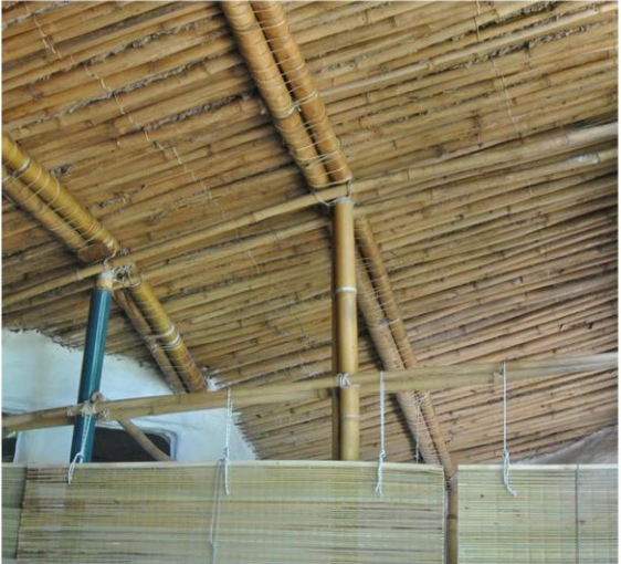
Interior: se aprecian las vigas curvas, el cielorraso de bambú y los paneles internos.
