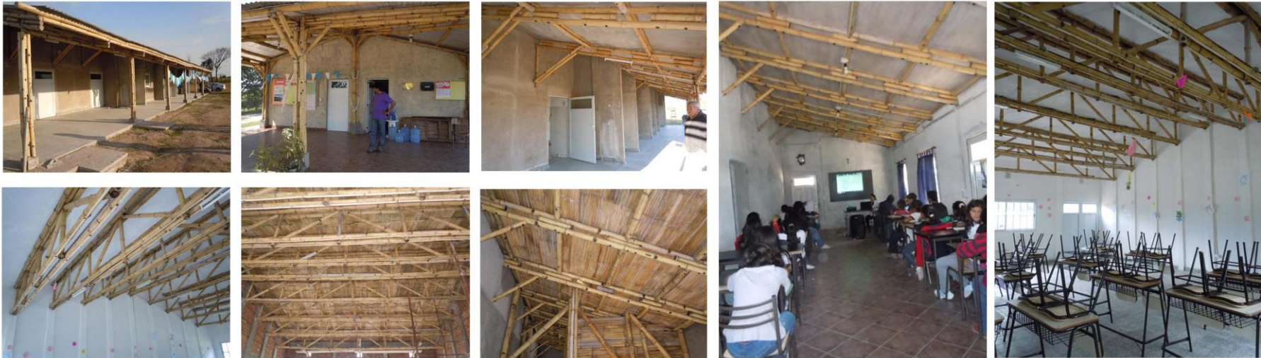
Se experimentaron distintas soluciones constructivas, realizadas siempre con uniones metálicas. Los elementos de la cubierta se constituyen por vigas compuestas en las luces más chicas, y por vigas reticuladas en las luces mayores. Las fotografías interiores dan cuenta del resultado estético de dicha decisión estructural. Documentación extraída de la presentación de H. Saleme en el seminario Construir con el Delta, en la Sociedad Central de Arquitectos, Abril 2014.
