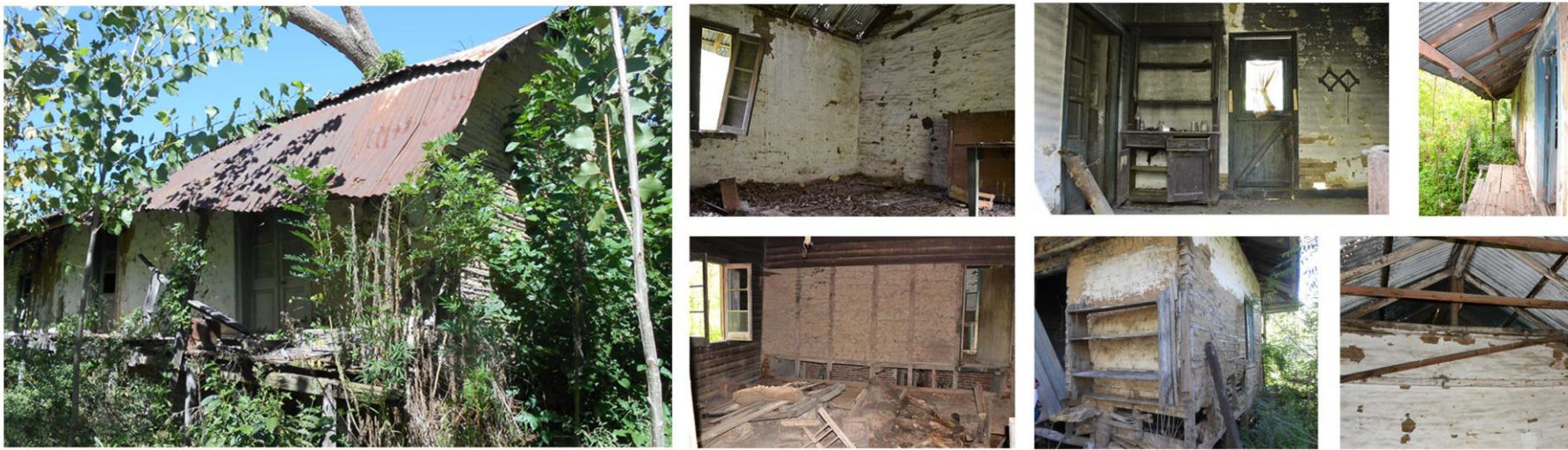
Fotografías exteriores e interiores de la vivienda realizadas dentro para el proyecto Construir con el Delta. Se aprecia el estado de conservación general y las diferentes técnicas utilizadas (fotos Ilaria Giacometti y ECMV 05-02-2014)
