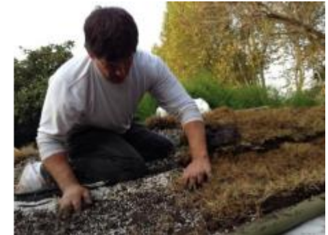
Construir con el delta: Techo extensivo realizado sobre estructura de bambú, combinando materiales reciclados y técnicas convencionales. De izquierda a derecha: Techo terminado (8-12-2014) , detalle y proceso constructivo (20-04-2014) (Fotos: EM y Clara Peña )
