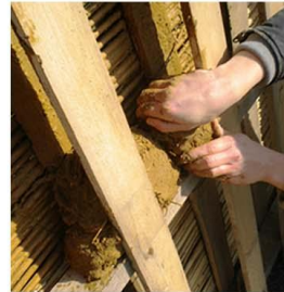
Preparación y aplicación de la mezcla
