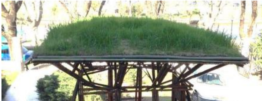
Construir con el delta: Techo extensivo realizado sobre estructura de bambú, combinando materiales reciclados y técnicas convencionales. De izquierda a derecha: Techo terminado (8-12-2014) , detalle y proceso constructivo (20-04-2014) (Fotos: EM y Clara Peña )
