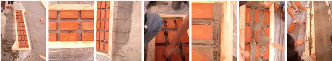
Componentes y montaje del sistema estructural y de envoltura BENO. Fuente: www.ceve.org.ar
