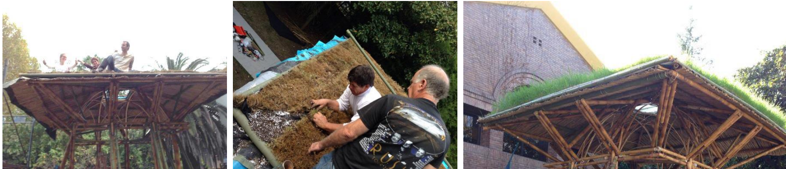
Culminación de la cubierta verde.
