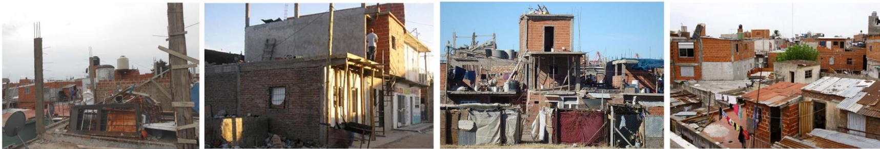
Gráfico 4: Propuesta de adecuación de casillas existentes. A la izquierda se detallan las características actuales de las casillas de las villas miseria y el esquema de crecimiento de las mismas. Se prevé un crecimiento gradual del módulo estructural base, dejando a la vista los hierros de las armaduras. La envolvente se realiza en general con ladrillos huecos de 8 cm sin revocar ni aislar hidrófugamente ni térmicamente. La cubierta puede realizarse con una losa plana (esperando posibles ampliaciones, o con cubierta de chapa a un agua). A la derecha se detalla la propuesta de adecuación, en donde una estructura independiente en bambú envuelve la casilla existente separando tanto la carga de la cubierta como la de la nueva envolvente de la estructura original.
