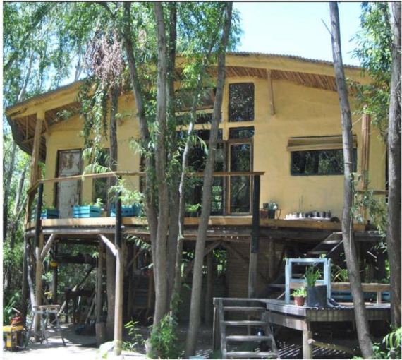
Vista general de la casa
