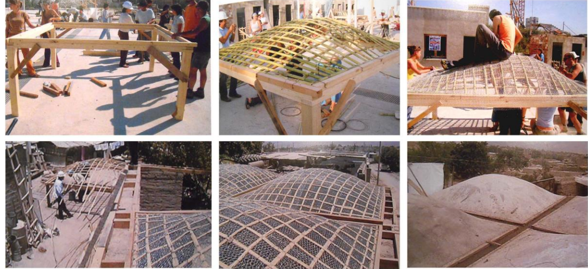
Fotos del proceso de construcción de la cubierta, fuente: Casa per tutti, abitare la città globale, Mondadori, Milano 2008: 196,197
