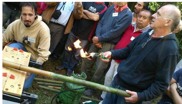
Izquierda: secado a la intemperie (fuente: Minke 2012) Centro: secado al calor con soplete durante el Workshop Construir con el Delta (créditos Roberto Bogani) Derecha: Método Boucherie modificado (fuente: Lic. Clara Peña DPDI)
