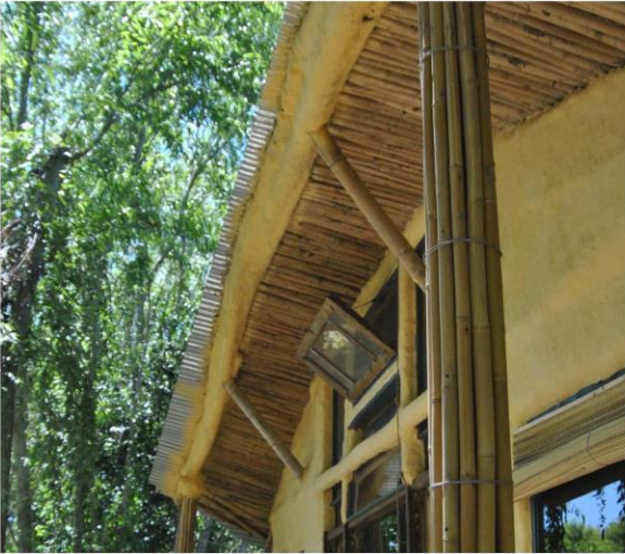
Exterior: Columnas realizadas con mazos de bambú en el deck exterior.
