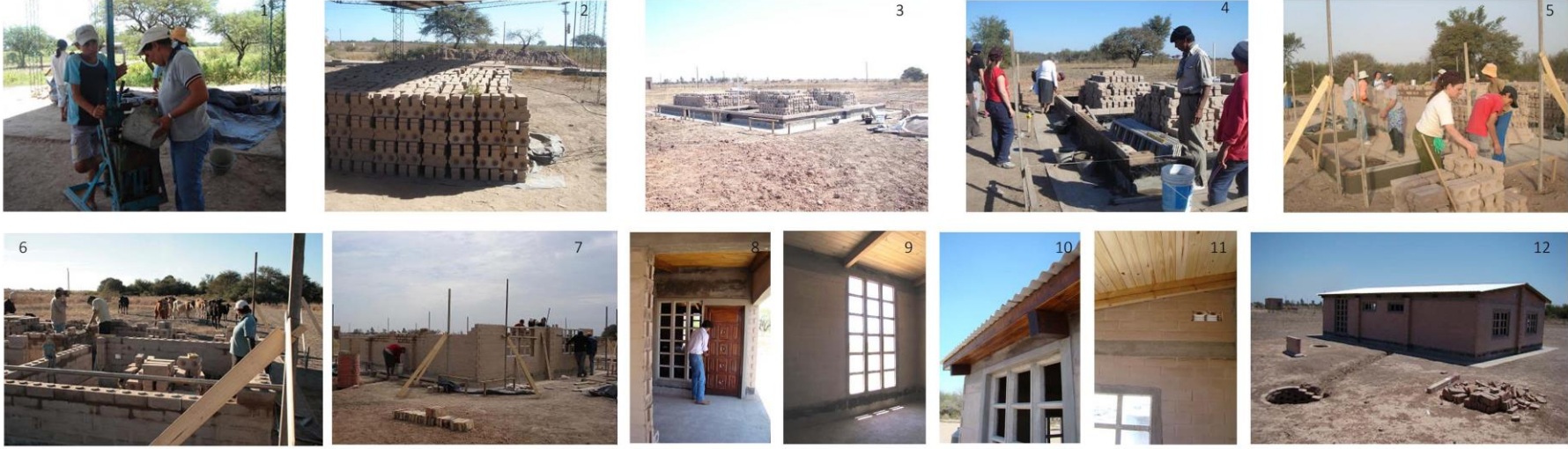
Fotos 1 a 7: Proceso de construcción obra-escuela, durante los 17 días de visita de los especialistas italianos. El completamiento de los trabajos se llevó a cabo por la mano de obra ya formada y representantes del CACOVI y la UTN. Fotos 8 a 11, detalles constructivos donde se aprecia la traba de los ladrillos, y la estructura de la cubierta de madera apoyada sobre la viga de hormigón perimetral. Foto 12: foto general de la casa terminada. fuente: http://celebratierra.blogspot.it/p/el-nochero-2009.html
