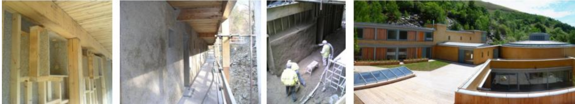
Ejecución de muros en cáñamo y resultado final en el edificio Wise del CAT Center de Borer y Lea. Fuente: Presentación de Pat Borer en el curso de excelencia Building Techniques with Natural Materials en el Politécnico de Turín 29 30 y 31 Octubre 2012
