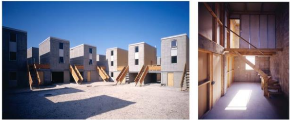
Uno de los patios, e interior de una de las viviendas recién terminadas. fuente: www.elementalchile.cl
