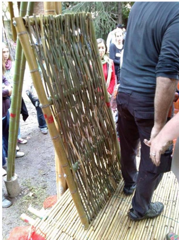
Izquierda superior: Detalle del manual elaborado por el CIDART para la realización del workshop en tierra. Imágenes del panel prefabricado en quincha estandarizada, pisadero, pruebas de campo y muro terminado. Fotos : DPDI 15 y 16 de Mayo 2014
