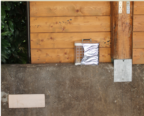
Fig. 6.34, 6.35, Il datalogger A è stato posizionato sotto una tettoia, al riparo da pioggia e da irraggiamento solare diretto.
