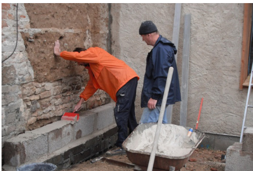
Fig. 6.51, Isolamento esterno con blocchi di calce e canapa. (Foto G. Paccoud)
