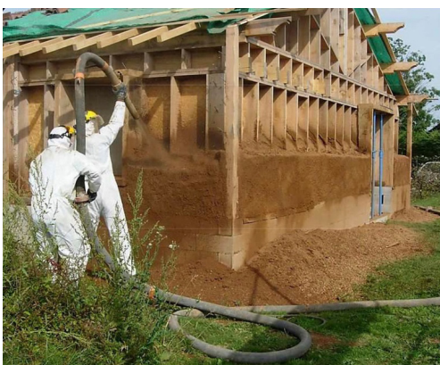
Fig. 6.53, Terra "proiettata" su struttura di supporto in legno: Entreprise PITANCE (Foto Gasnier)
