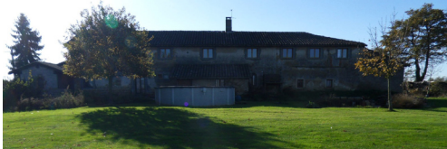
Fig. 6.26, 6.27, la realizzazione di un secondo piano abitato crea la necessità di nuove aperture.
