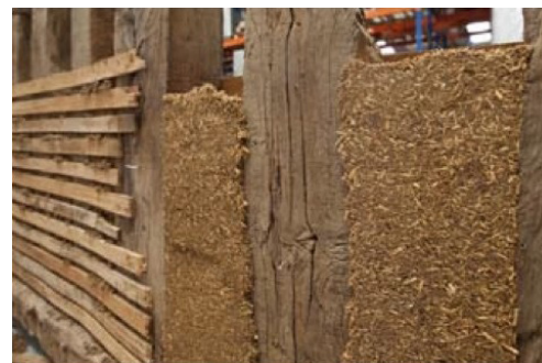
Fig. 6.48, Isolamento con materiale sfuso a base di fibre e terra con struttura di supporto in legno e cassero a perdere realizzato con fascette in legno. (Foto Le Paih, et aii, Rennes 2009)
