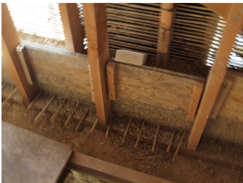
Fig. 6.49, Isolamento con materiale sfuso a base di fibre e terra con struttura di supporto in legno e cassero a perdere realizzato con incannucciato. (Foto Paccoud, St. Didier sur Chalaronne 2010)
