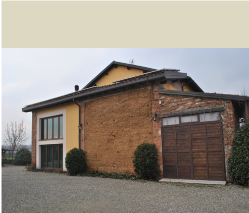
Fig. 6.31, Cascina Giacobbe, facciata Sud-Est; si nota la porzione di parete in terra battuta, a chiusura del portico, lasciata a vista.
