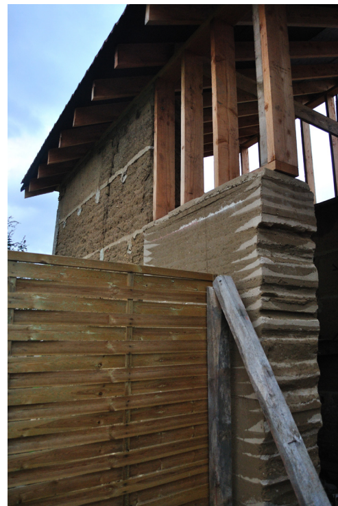
Fig. 5.30, La porzione di parete sud ricostruita in terra battuta; si nota il sistema utilizzato per rinforzare gli angoli, posizionando mucchietti di calce negli angoli delle casseforme, ogni due strati successivi di terra compattata.
