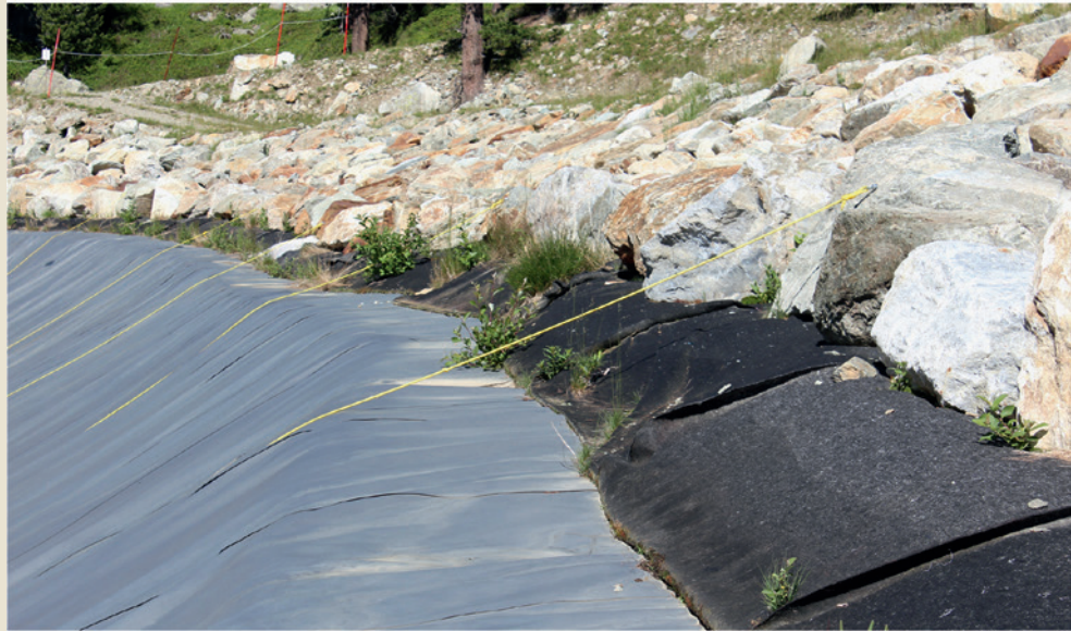
FIGURE 4 a) Recouvrement en partie supérieure sur risberme ; b) "Chaussette" de géotextile ; c) Absence de structure de protection.
