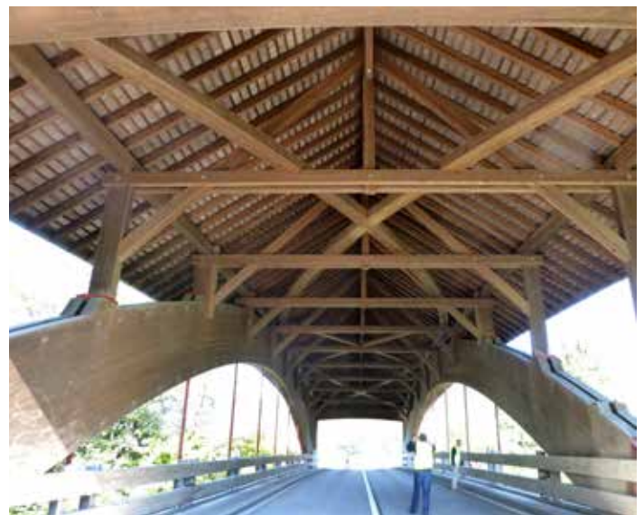
Buebeneibrücke a Signau (fotografia di T. Marzi).
