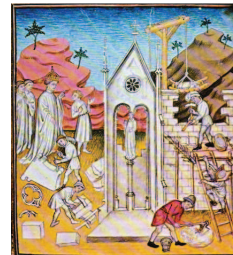
Figura 2 - Cantiere con carrucole, ponteggi e attrezzi da scalpellino (da Grandes Chroniques de Saint-Denis) sec XIV.
