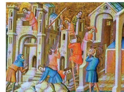
Figura 1 - Cantiere di cattedrale. Codice miniato Selterio di Canterbury sec. XII - Victoria and Albert Museum - Londra
