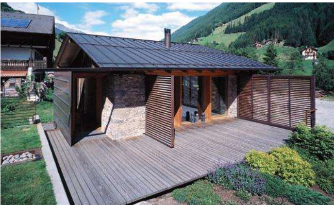
Figura 13 Em2 Architetti, risanamento di una casa in Valle Aurina (BZ), 2000-2004
