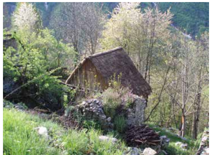
Parco Alpi Marittime, Roaschia. Tetti Virutra. Tetto in paglia di segale (fotografia di R. Ansaldi).
