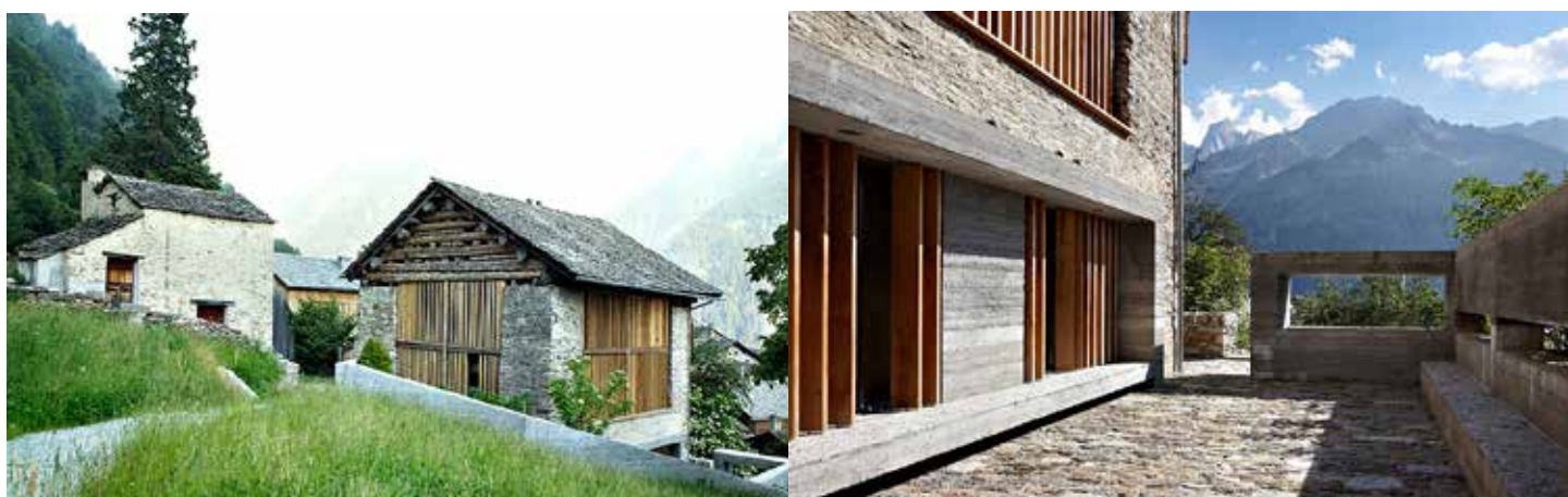
Soglio. Ristrutturazione di un fienile. Armando Ruinelli.
