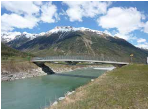
Samedan. Ponti sul fiume Flaz. Ing. Pedrazzini-Guidotti
