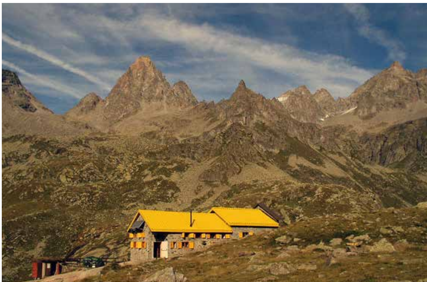
Nel Parco naturale del Gran Paradiso le acque di scarico dei rifugi Pontese (quota + 2200 m) e Savoia (quota + 2534 m) verranno trattate dai rispettivi impianti di bio-pedodepurazione, la cui progettazione è attualmente (giugno 2014) alla fase definitiva.
