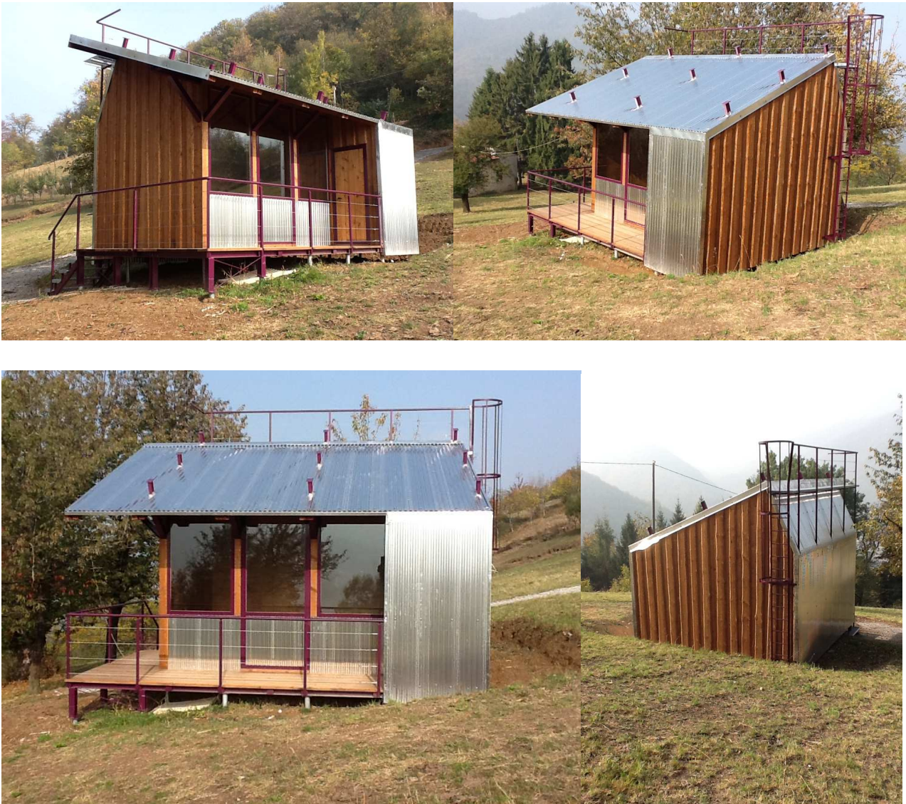
6. Viste dell'unità sperimentale terminata.
