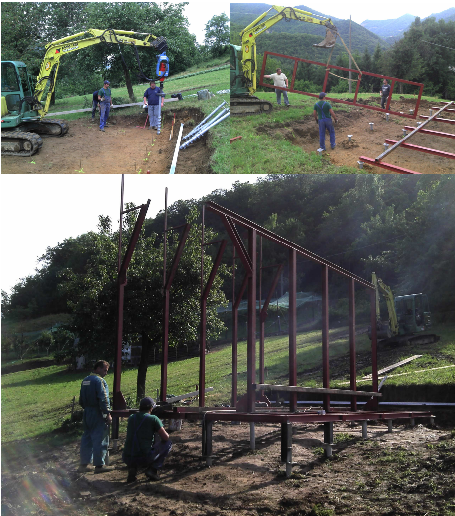
2.Fase iniziale costruzione scheletro della stazione sperimentale
