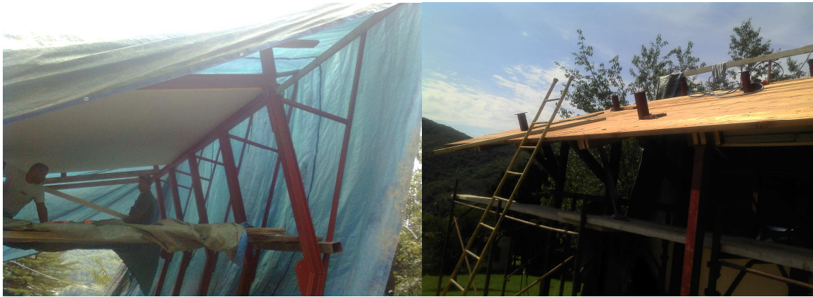
2. Realizzazione involucro della stazione sperimentale.
