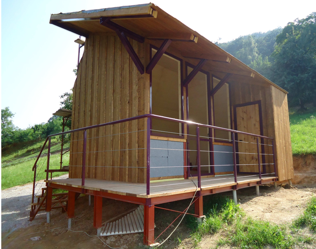
4. Realizzazione infissi e finiture esterne.
