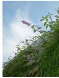
Figura 2.3: Cella di prova GReens Environment park.
