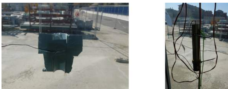
Figura 5.7: Schermatura di termocoppie.
