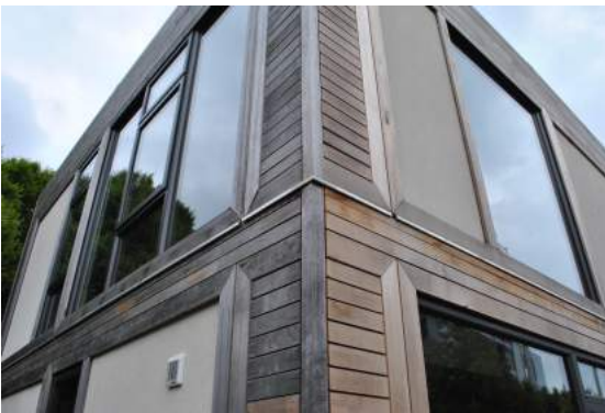
Figura B.10: Differenza di colore della pannellatura lignea: i listelli più chiari sono stati sostituiti dopo lo smontaggio e rimontaggio dell'edificio.
