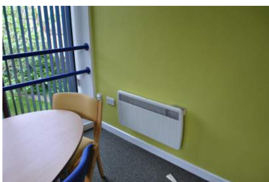
Figura B.6: Presenza di riscaldamento elettrico.
