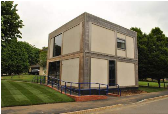
Figura B.2: Esterno della BaleHouse. Nessuna protezione per le chiusure che risultano sempre esposte alle piogge.
