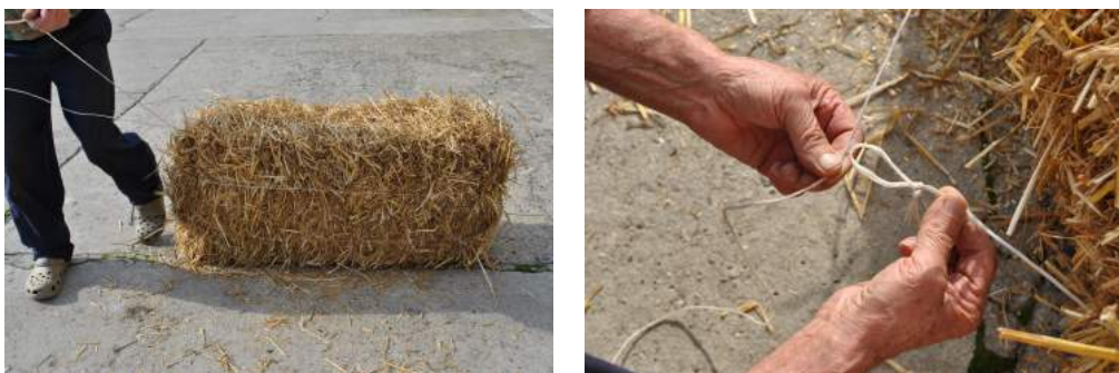
Figura A.2: Passaggio filo attorno alla balla; fase di legatura
