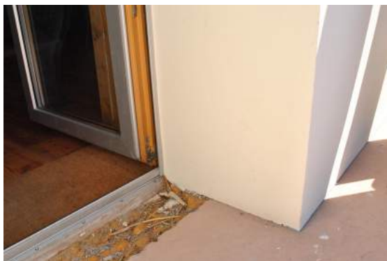
Figura D.8: Particolare esterno della porta di ingresso alla sala da pranzo: in evidenza lo spessore di isolamento (parte intonacata) e mantenimento posizione vecchio serramento (A.R. Bertorello, 04.05.13)
