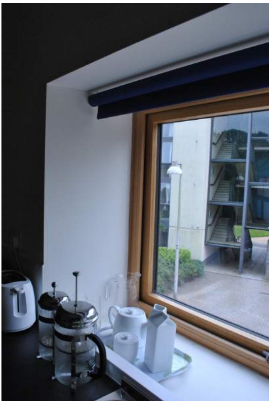
Figura B.4: Oscuramento interno della cucina: tenda avvolgibile inserita nella parte superiore del vano finestra. Nessuna protezione all'esterno per il controllo della luce.
