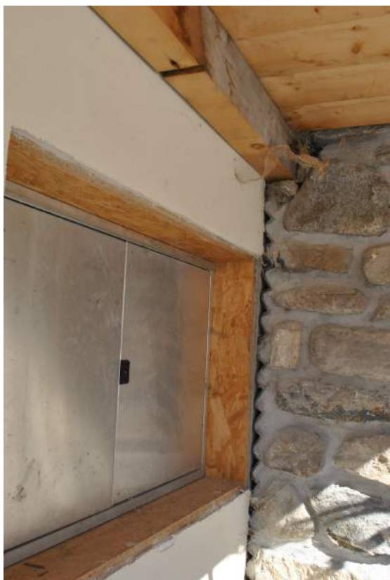
Figura D.12: Particolare del sottoscala esterna: presenza di lastra ondulata metallica collocata in aderenza alla chiusura verticale isolata. Questo permette la ventilazione dell'area interessata dalla presenza della scala in pietra e la separazione dalla stessa (A.R. Bertorello, 04.05.13)
