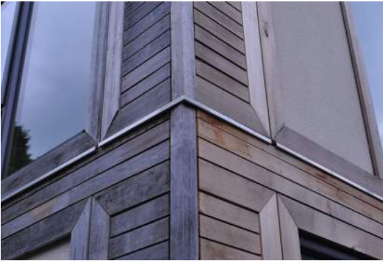
Figura B.9: Particolare esterno angolo della finitura esterna.
