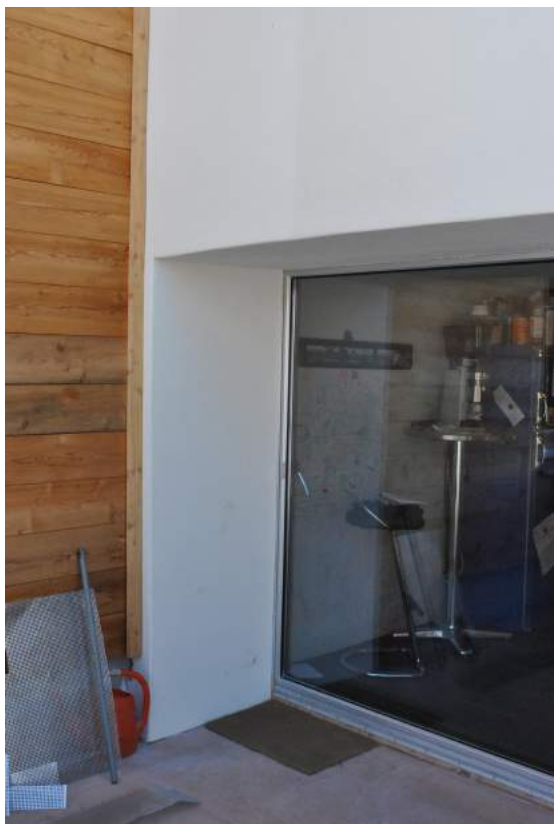
Figura D.6: Porta di ingresso alla cucina: spessore isolamento (parte intonacata) e mantenimento posizione del vecchio serramento (A.R. Bertorello, 16.03.13)
