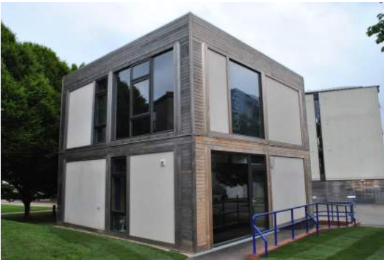
Figura B.11: Differenza nella modularità dei pannelli ModCell impiegati nella realizzazione dell'edificio (pannelli pieni, pannelli completamente vetrati, pannelli misti (vetrati e opachi)).
