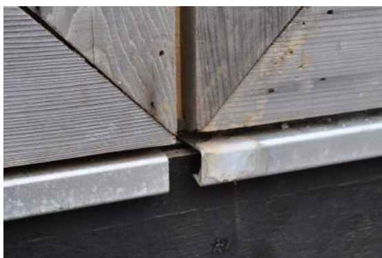
Figura B.16: Particolare gocciolatoio presenti nella parte inferiore di ogni pannello ModCell
