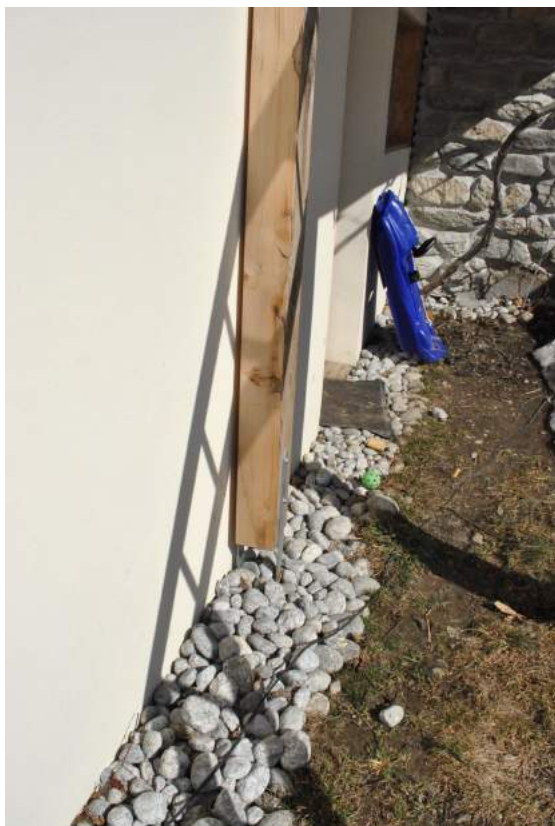
Figura D.13: Particolare dell'attacco a terra dell'abitazione: presenza di ghiaia per drenaggio in prossimità della base dell'isolamento (realizzato in vetro cellulare) (A.R. Bertorello, 04.05.13)
