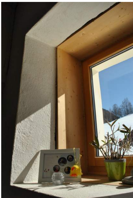
Figura D.7: Particolare di una finestra interna in cui il serramento, dopo la sostituzione è stato arretrato verso l'esterno (A.R. Bertorello, 16.03.13)
