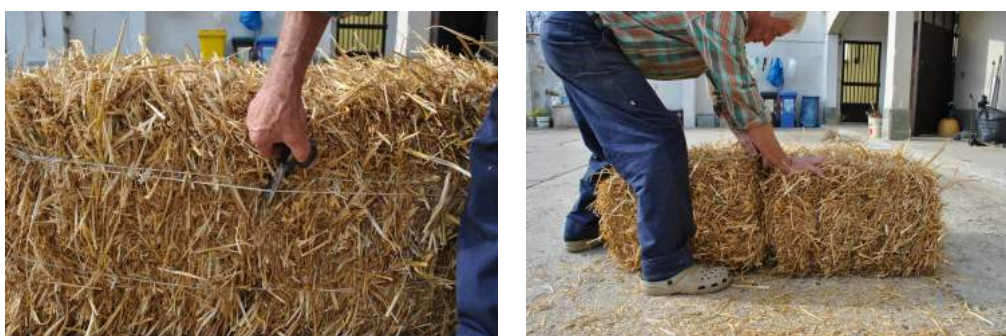
Figura A.7: Taglio delle legature originarie; separazione delle balle
