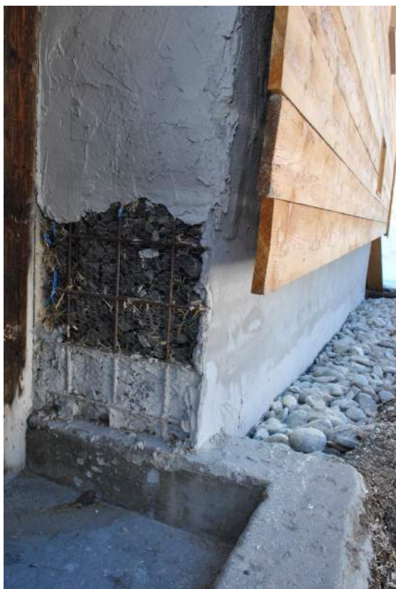
Figura D.14: Particolare del basamento della nuova estensione in paglia realizzato in vetro cellulare (A.R. Bertorello, 04.05.13)
