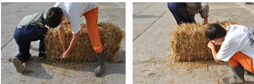
Figura A.4: Serraggio seconda legatura (La2); realizzazione terza legatura (La3)
