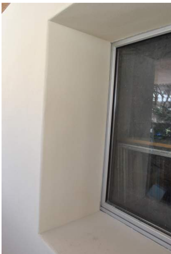
Figura D.11: Spalla esterna di un'apertura: mantenimento posizione arretrata del serramento e davanzale esterno intonacato (assenza di gocciolatoio) (A.R. Bertorello, 04.05.13)
