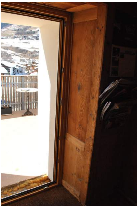
Figura D.9: Particolare interno della porta di ingresso alla sala da pranzo: la muratura esistente in pietra all'intero è stata rivestita in legno (pannellatura originaria) (A.R. Bertorello, 04.05.13)
