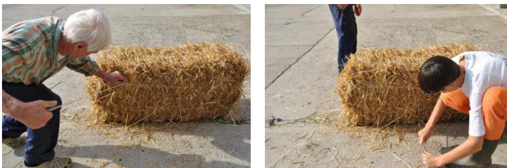
Figura A.3: Serraggio della legatura (La1); nuova legatura nella parte inferiore (La2)
