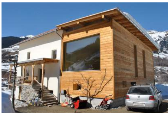
Figura D.2: Nuova estensione dell'abitazione realizzata in paglia con rivestimento in legno (A.R. Bertorello, 16.03.13)
