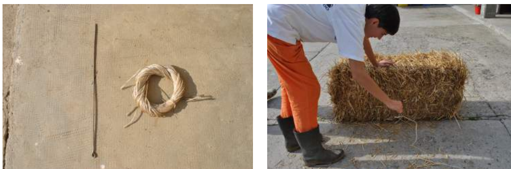
Figura A.1: Materiale occorrente per il lavoro di taglio; passaggio della bacchetta in ferro attraverso la balla
