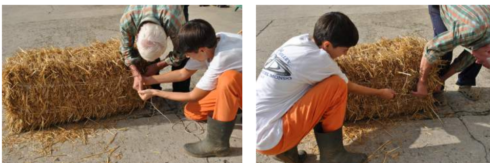
Figura A.5: Trattenimento e fissaggio della terza legatura (La3); serraggio quarta legatura (La4)
