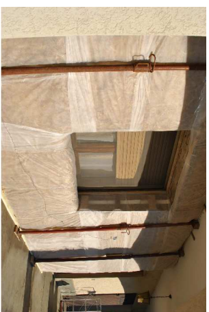
Isolamento in paglia realizzato
