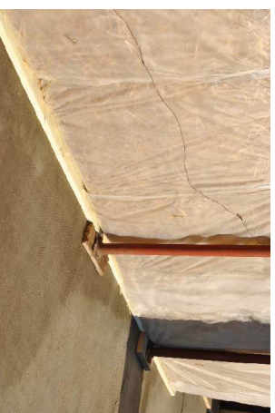
Parte inferiore intervento di isolamento in paglia
