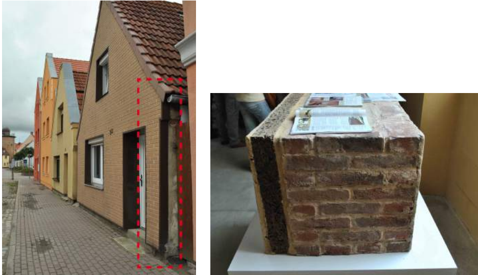
Figura 2.1: intervento di isolamento dall'esterno di edificio esistente in cui viene evidenziato l'isolamento esterno applicato sulla facciata principale dell'abitazione (Germania del Nord) (A.R. Bertorello, 27 agosto 2010); a destra: modello al vero della chiusura verticale della zona espositiva di Nova Civitas – Fondazione Pistoletto (Biella) isolata dall'interno con lastre di sughero (A.R. Bertorello, 28 ottobre 2011)
