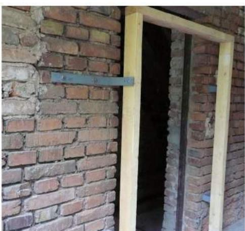
Realizzazione telaio in legno, fissato alla muratura esistente e proiettato verso l'esterno. Servirà come supporto per il nuovo infisso. In questo modo, gli infissi vengono spostati verso l'esterno e non sono più inseriti nella posizione di quelli esistenti.
