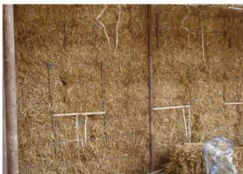
Ancoraggio di 3 corsi (lunghezza 120 cm) verticali di balle di paglia mediante l'impiego di rami di legno inseriti tra i corsi delle balle. I rami verticali, trattenuti dai fili delle balle di paglia, sono collegati orizzontalmente con un nastro in polipropilene in modo da creare un ancoraggio ad H.
