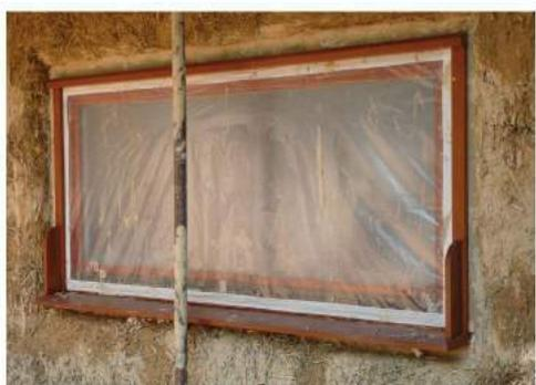
Inserimento di un telaio di legno di quercia per coprire le fessure che si sono venute a creare tra il telaio di supporto dell'infisso e il serramento.
