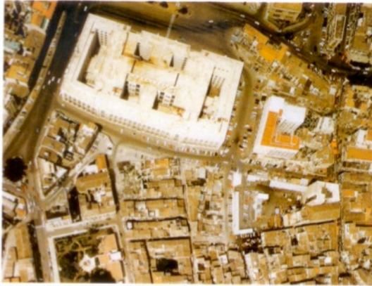
6.1.3 Fig. 5: Vista zenitale dell'area prima dell'intervento
