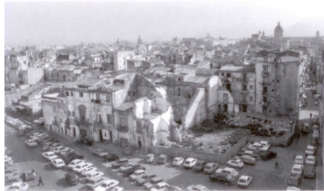
6.1.3 Fig. 7: L'isolato dopo i crolli
