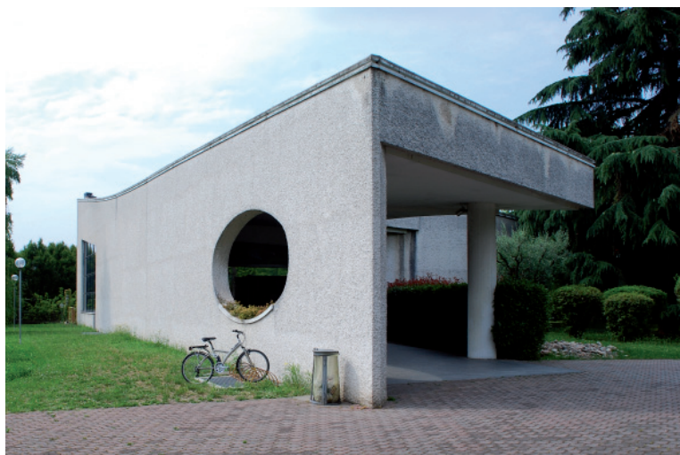
06 La marquesina de entrada; detalle del óculo.
