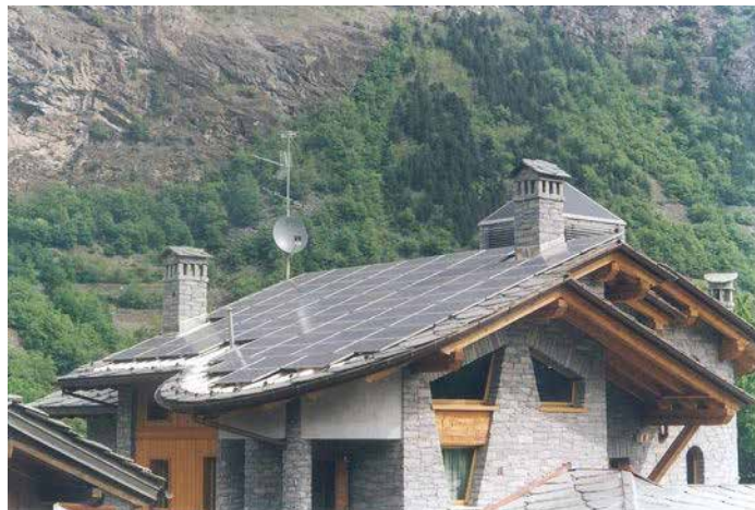
Inserimento di pannelli solari nella copertura in lose
