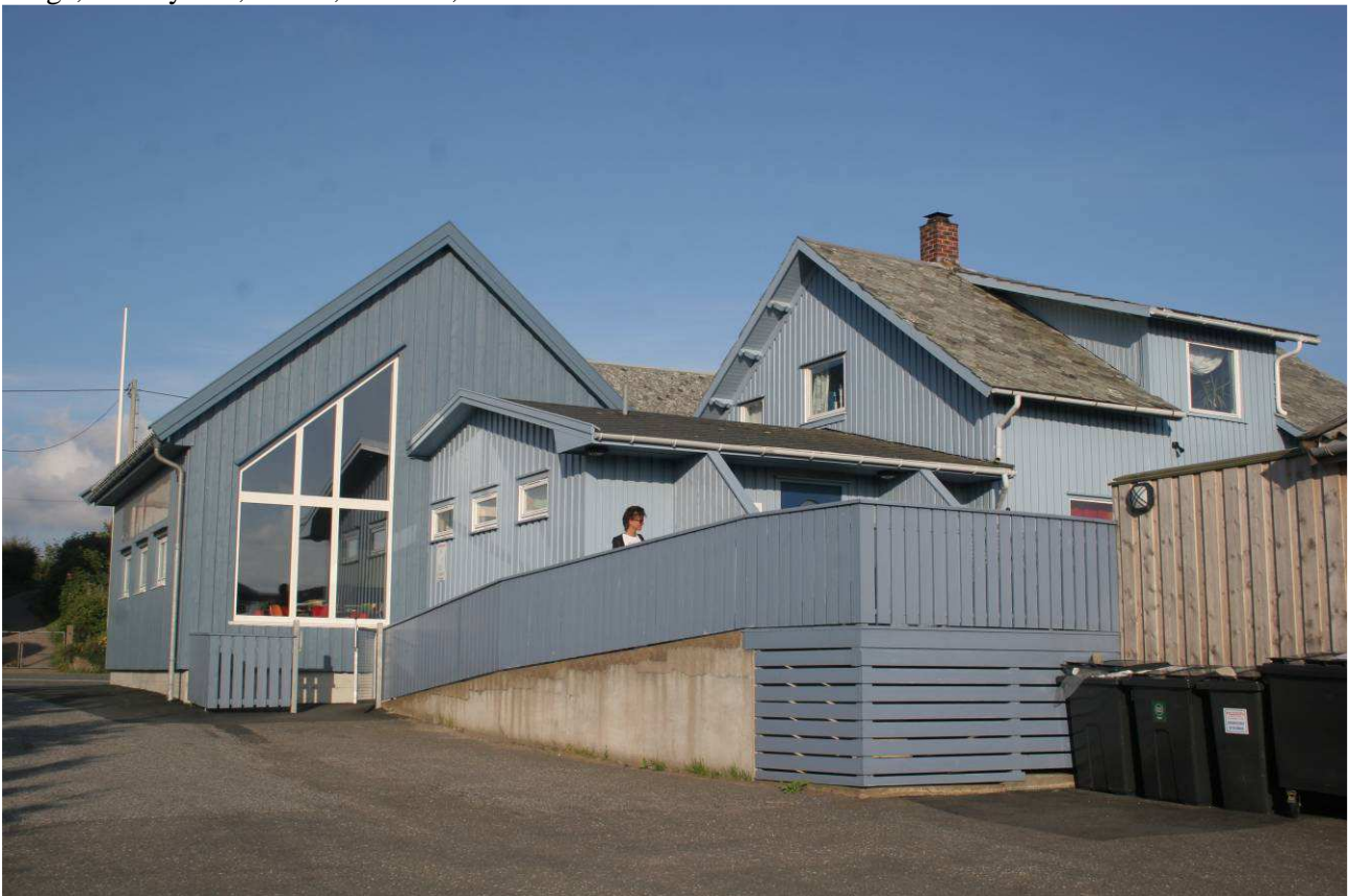
Escuela materna de Borhaug, Farsund, Noruega. Arquitecto: Bjørn Berge – Gaia Lista.
