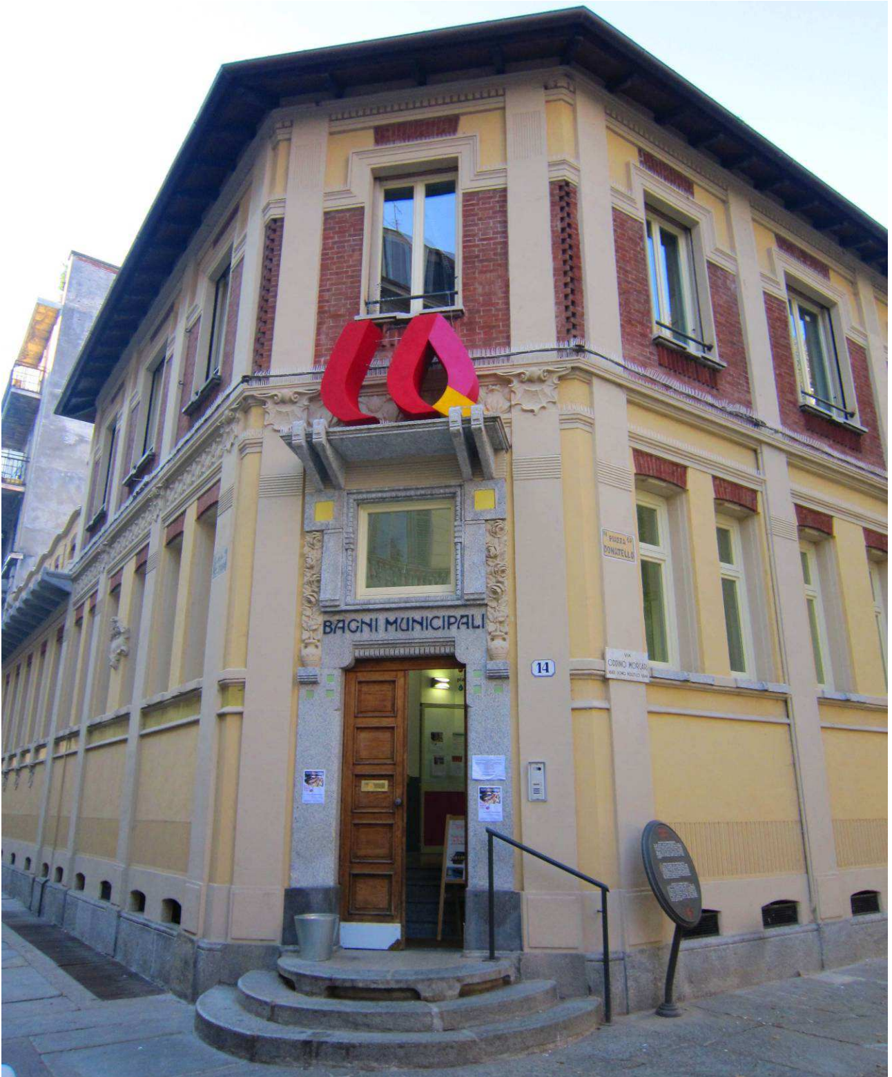
Conversión del edificio de los antiguos baños comunales, en la Casa del Quartiere di San Salvario, Turín, un laboratorio de actividad social y multicultural abierto a toda la comunidad. Agencia para el Desarrollo Local de San Salvario.
