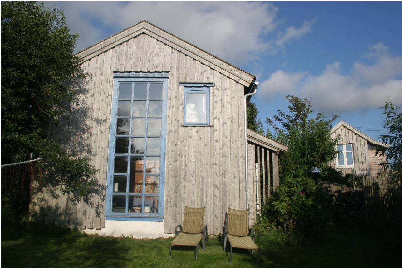
Transformación de un granero para uso habitacional, Jølle, Farsund, Noruega. Arquitecto: Bjørn Berge – Gaia Lista.
