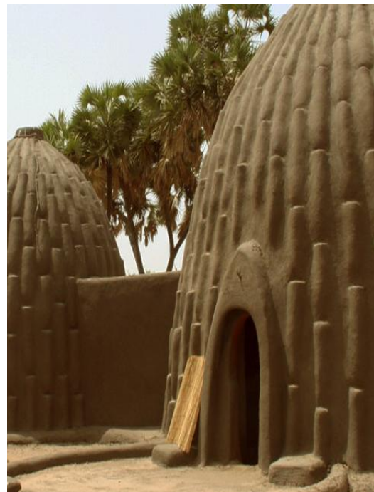
Casa obice in terra cruda - Camerun
