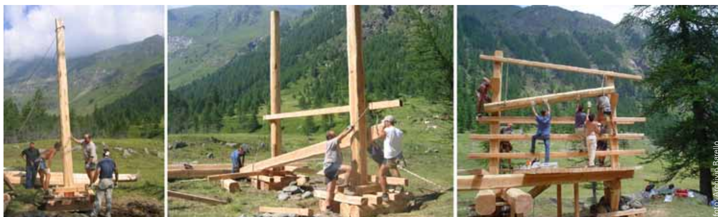
Torretta per l'osservazione della fauna selvatica-Montaggio della struttura principale
