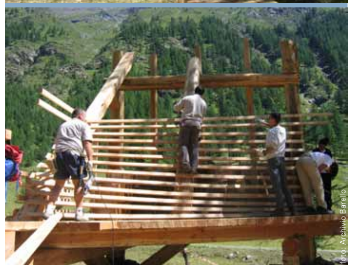
Fasi di montaggio della torretta
