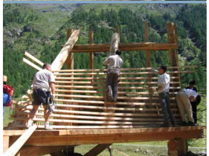
Fasi di montaggio della torretta
