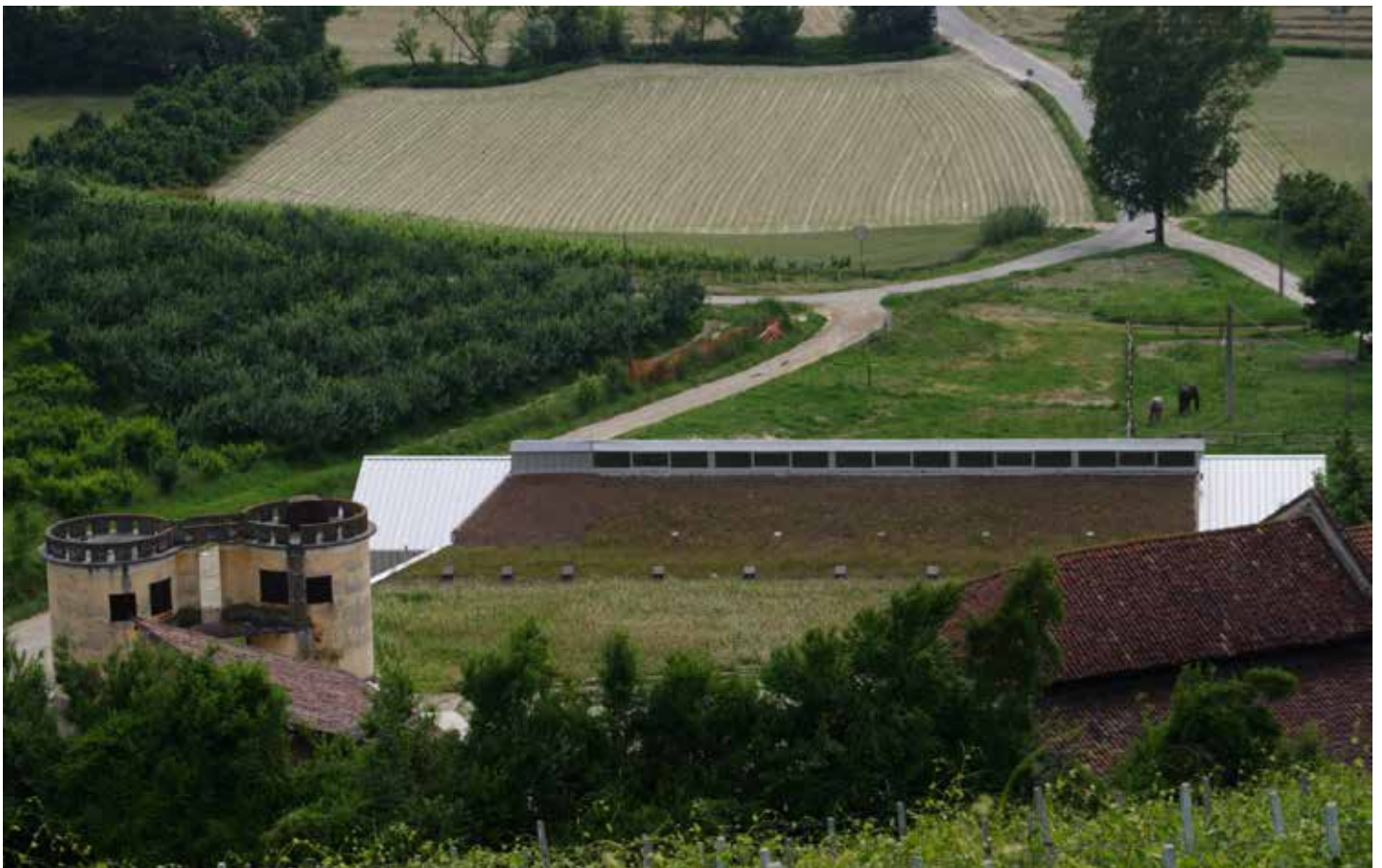
Vecchi contenitori e nuovi contenuti: un capannone per bovini diventa cascina (Cascina Val del Prete, progetto a cura di BD Architetti)
