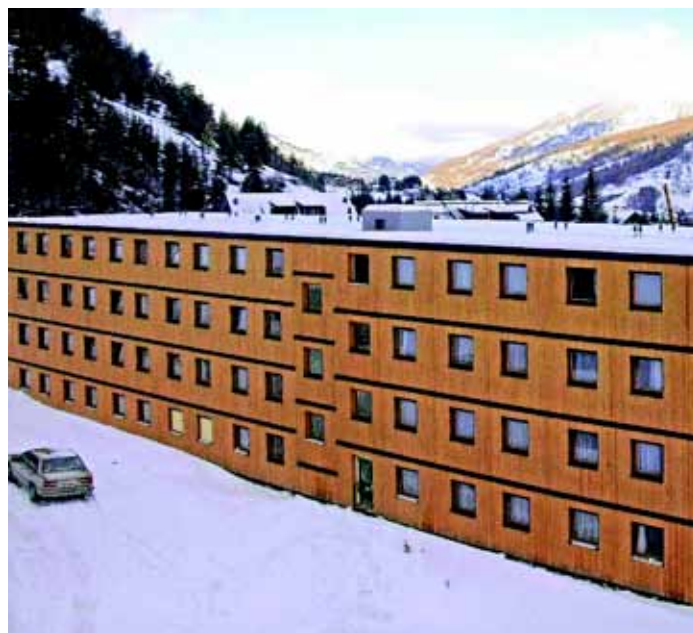
Alloggi temporanei, arch. ing. T. Kudela, ing. V. Kadera, J. Riebenbauer. Olimpiadi invernali Torino 2006.
