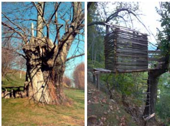
Un vecchio castagno usato come "casetta" e una "casa sull'albero" in pali di castagno.
