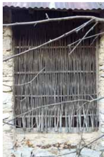
Le divisioni e i tamponamenti (grate, muri non portanti, tramezze) sono spesso fatte di ramaglie e pertiche.
