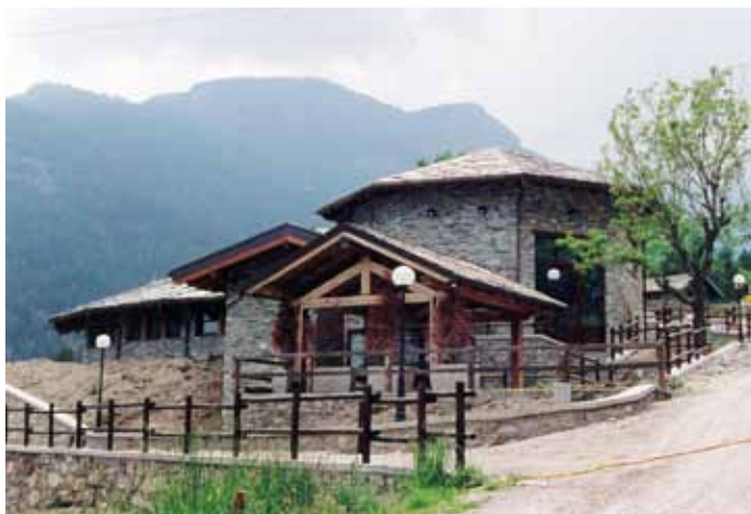
Esterno del centro visita.
