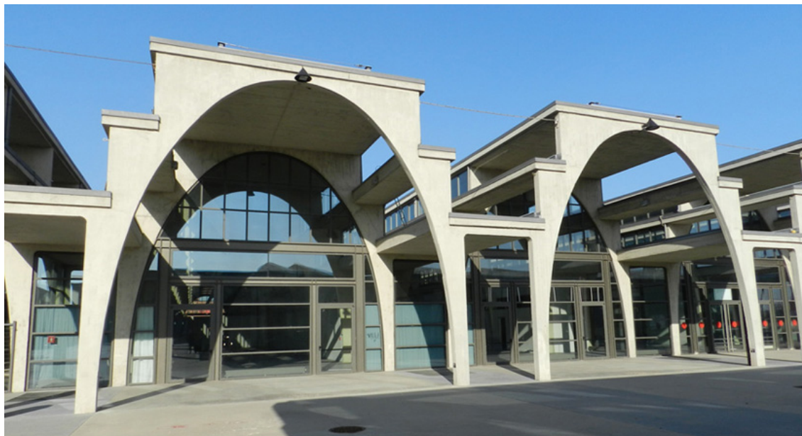
Figura 13. Torino, Mercati Generali, 1932-37. Il tamponamento vetrato di uno dei corpi centrali (foto Mattone).
