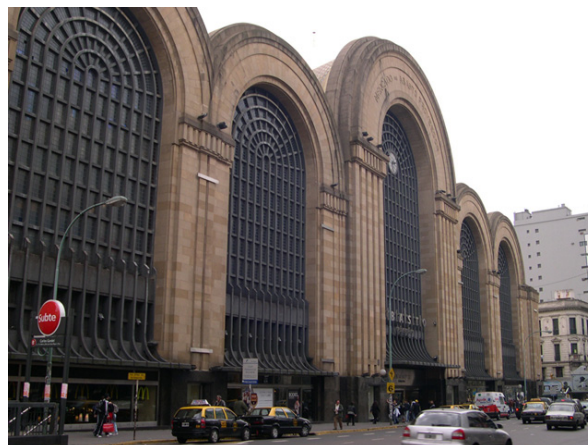
Figura 3. Buenos Aires, Mercado de Abasto Proveedor, 1929-34. Prospetto principale. Foto: Mattone.
